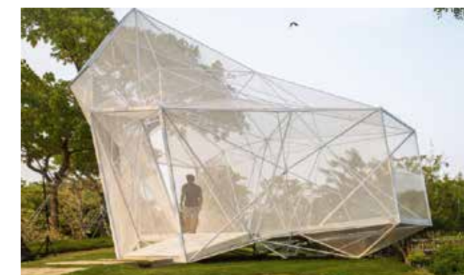
Edificio temporaneo realizzato con acciaio stampato in 3D, Architectural Intelligence Research Lab, 2020 da https://www.springwise.com
