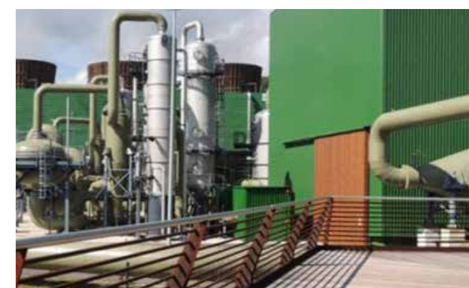
Centrale geotermica di Triana sul monte Amiata, Toscana IT da https://www.cosvig.it
