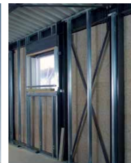
Foto di cantiere da: https://www.vanoncini.it
