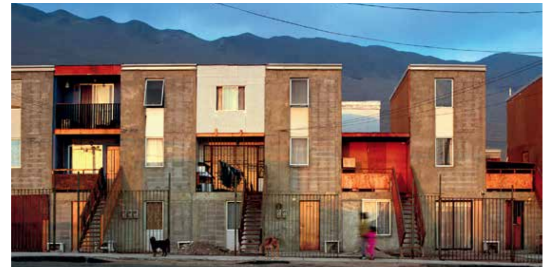
Alejandro Aravena, progetto di quartiere residenziale a Quinta Monroy, Iquique (Chile), 2001-2004 da https://arquitecturaviva.com
