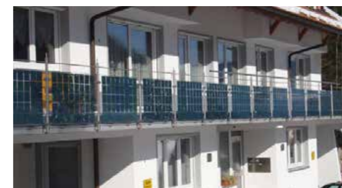
Parapetto fotovoltaico da: http://www.solarbuildingtech.com
