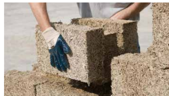
Blocchi in calce-canapa da: www.canape.bio
