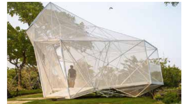
Edificio temporaneo realizzato con acciaio stampato in 3D, Architectural Intelligence Research Lab, 2020 da https://www.springwise.com
