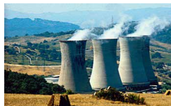
Centrale geotermica da http://www.risparmio-energetico.com
