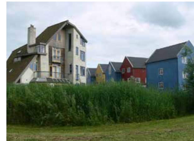
Casa autocostruita nell'eco-quartiere Lanxmeer nei Paesi Bassi da: https://it.m.wikipedia.org/wiki/File:E.V.A._LanxmeerSelfconstruction
