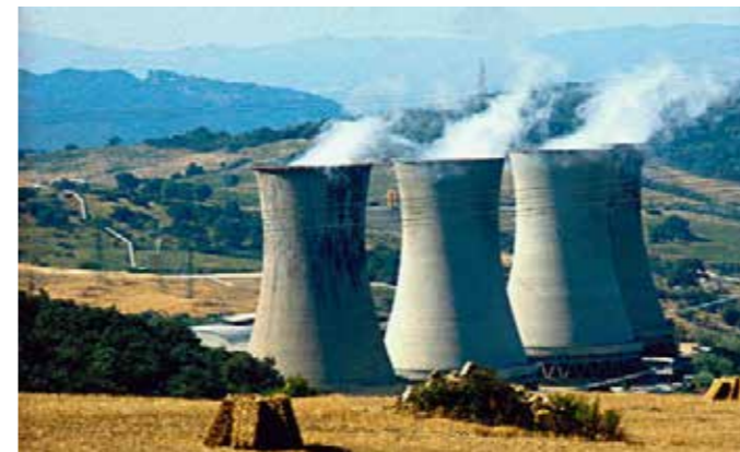
Centrale geotermica da http://www.risparmio-energetico.com
