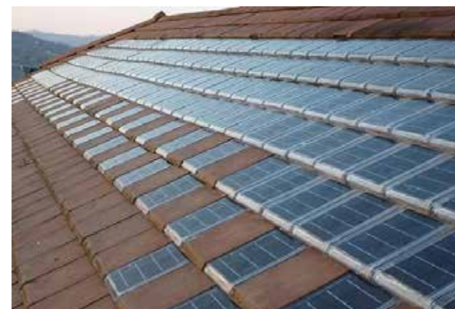
Copertura con tegole fotovoltaiche da: https://www.lavorincasa.it
