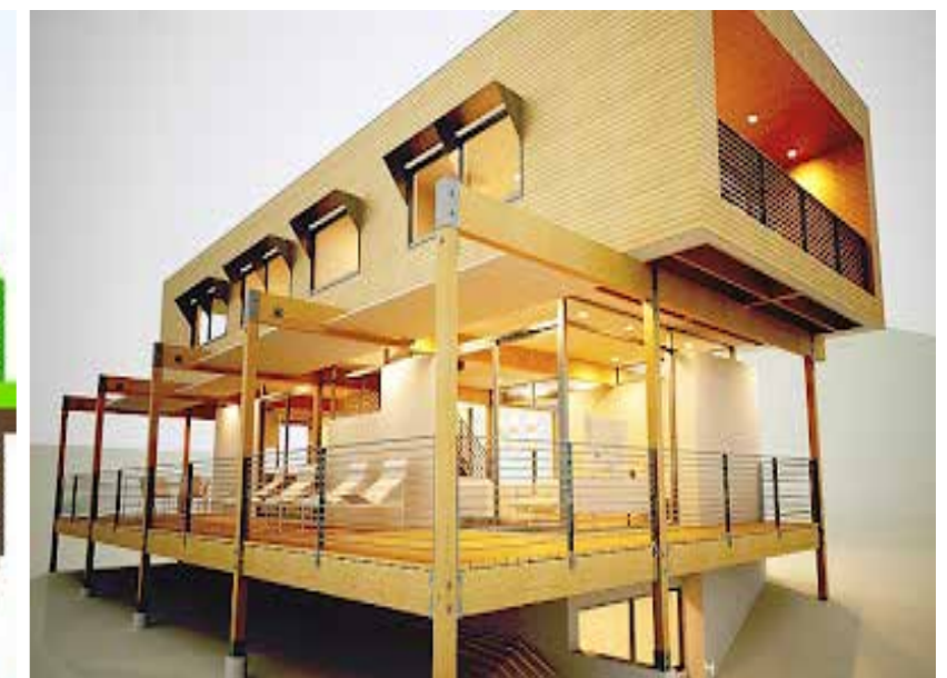
Prefabbricazione e eco-compatibilità a prezzi accessibili: il modulo prefabbricato si integra alla struttura portante in legno con connessioni in acciaio a vista, che consentono un facile assemblaggio e disassemblaggio dei componenti, per un potenziale recupero da: architetturareversibile.blogspot
