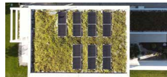
Tetto verde con pannelli fotovoltaici da: https://www.daku.it
