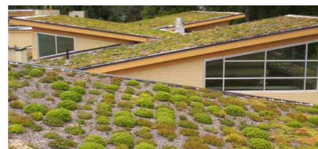
Tetto verde estensivo da: https://www.infobuild.it
