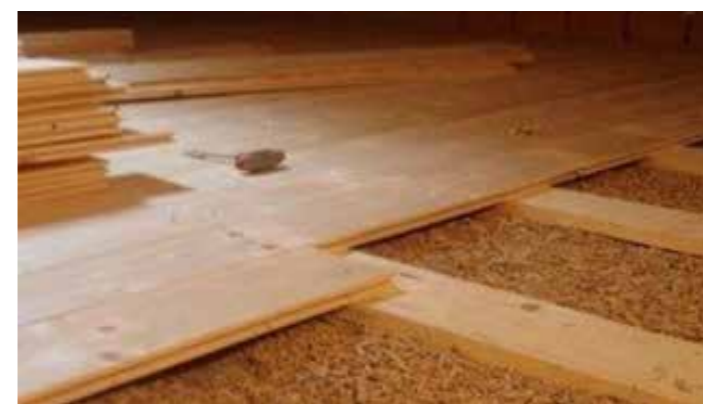
Isolamento sottopavimento in fibra di legno da https://www.ecostili.it
