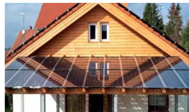
Pensilina fotovoltaica da: https://www.fotovoltaiconorditalia.it
