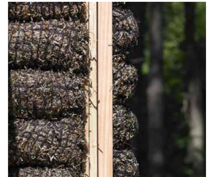
Isolamento realizzato con alghe da: https://vandkunsten.com
