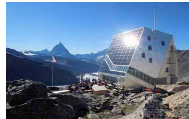
Capanna Monte Rosa, con vista dei numerosi pannelli fotovoltaici da: https://www.inalto.org
