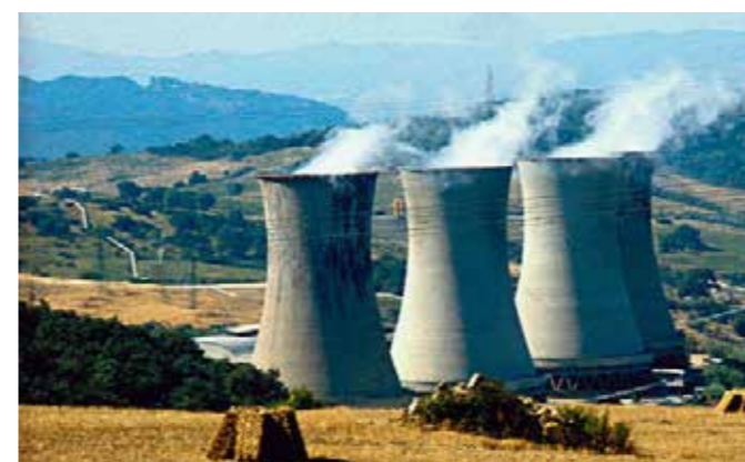
Centrale geotermica da http://www.risparmio-energetico.com
