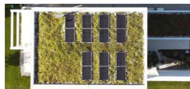
Tetto verde con pannelli fotovoltaici da: https://www.daku.it
