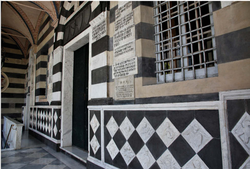
fig. 2 – Genova. San Francesco del Castelletto. Prospetti nord del chiostro del capitolo (ROSSINI 2020, p. 56) e ovest, con portale della sala del capitolo divenuta in seguito oratorio dell’Immacolata Concezione (foto dell’autrice).
