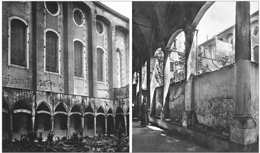
fig. 5 – Napoli. Santa Chiara. Fotografie storiche di inizio XX secolo con particolari del chiostro dei frati sul fianco della chiesa e sul lato opposto con parte delle arcate tamponate (Alinari, collezione privata).
