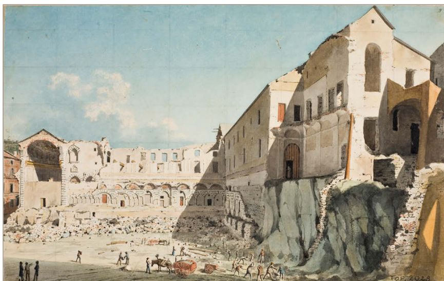
fig. 3 – Genova. Luigi Garibbo, Il cantiere di demolizione della chiesa e del convento di San Domenico , 1825, Genova (Collezione Topografica del Comune, Inv. 2028, DocSAI – Collezione cartografia e topografica foto Wikimedia Commons).
