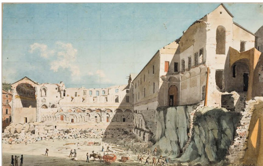
fig. 3 – Genova. Luigi Garibbo, Il cantiere di demolizione della chiesa e del convento di San Domenico , 1825, Genova (Collezione Topografica del Comune, Inv. 2028, DocSAI – Collezione cartografia e topografica foto Wikimedia Commons).
