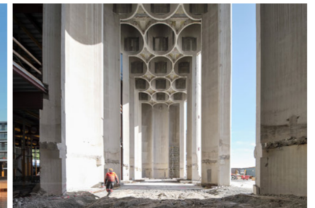
Figg. 18, 19 - Il Kunstsilos oggi (fonte immagine: https://www.kunstsilos.no/en ) e in un momento del cantiere (fonte immagine: https://mendozapartida.com/ ); sono visibili i silos, "tagliati" per far spazio alla nuova costruzione.
