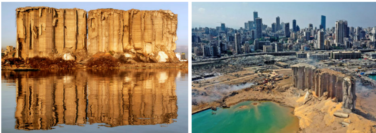
Fig. 1, 2 - I silos di Beirut dopo l'esplosione (fonte immagini: https://www.icomos.org/en/get-involved/inform-us/heritage-alert/current-alerts/108048-icomos-heritage-alert-beirut-grain-silos ).
