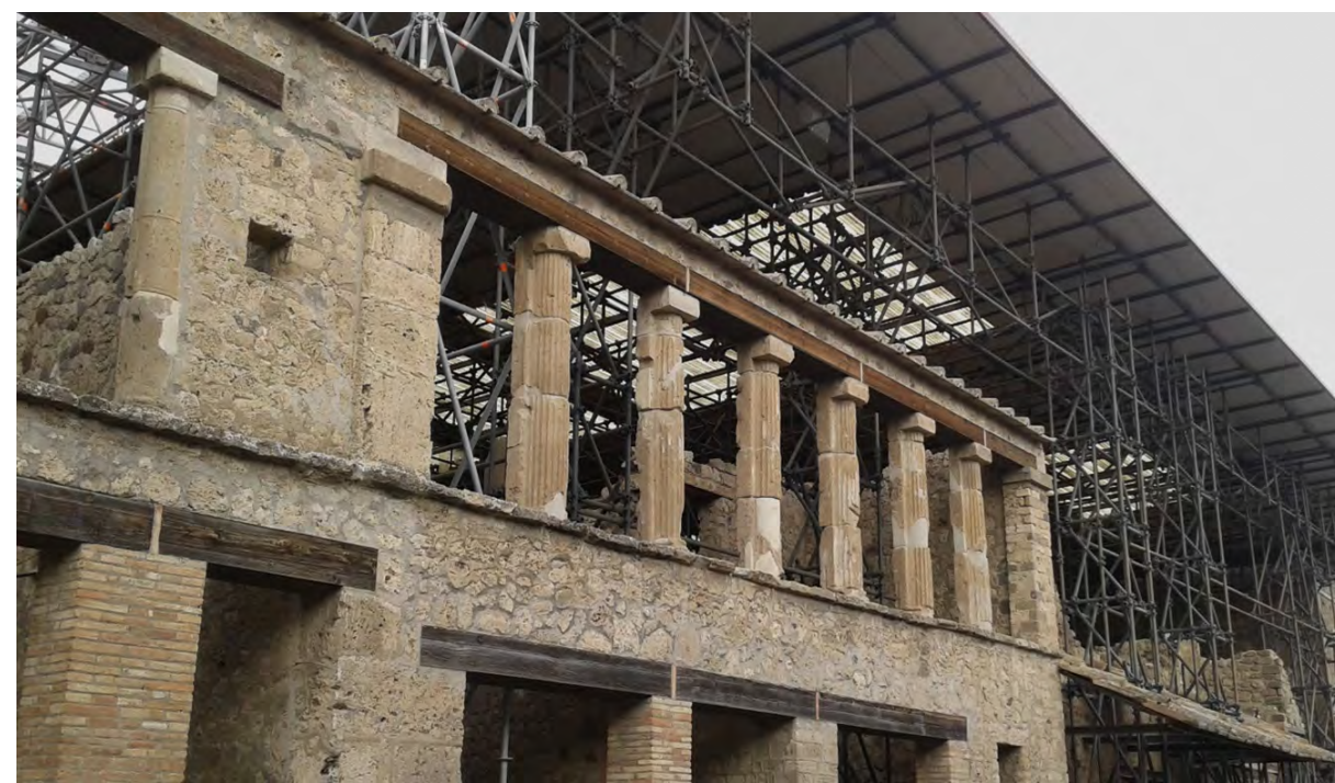
Fig. 10, 11 - In alto, Pompei, gli allestimenti didattici all'ingresso della Schola Armaturarum, sostituiscono, in parte la visita del monumento, in attesa del suo intervento di consolidamento e restauro. In basso, Pompei, il progetto di protezione della Casa dei Casti Amanti consente la parziale apertura al pubblico del monumento. Il coinvolgimento diretto dei visitatori, ha attuato la pratica della ‘live restoration’, come progetto compatibile di conservazione del patrimonio archeologico. Foto E. Romeo 2016.
