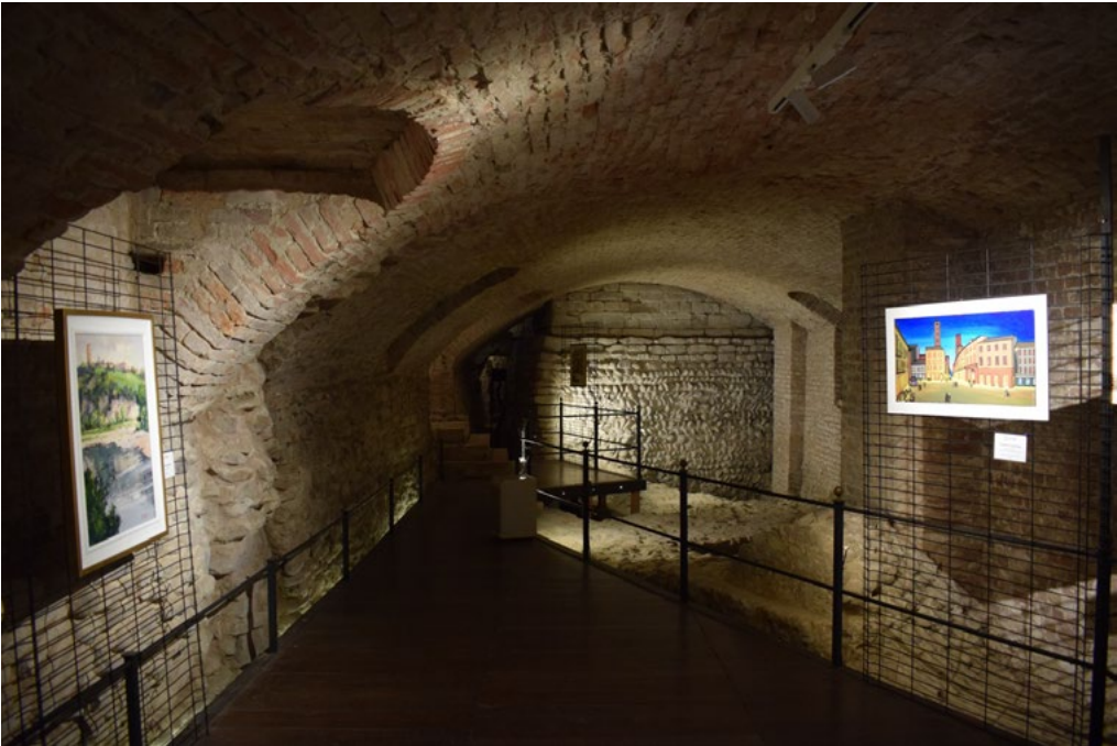
3: Interno del percorso archeologico. Si noti la struttura voltata realizzata nel XIV secolo come scantinato delle abitazioni, poi trasformato in deposito della chiesa sino all'intervento di restauro. Ai lati, alcune opere della pinacoteca, 2022 [Fotografia dell'autore].
