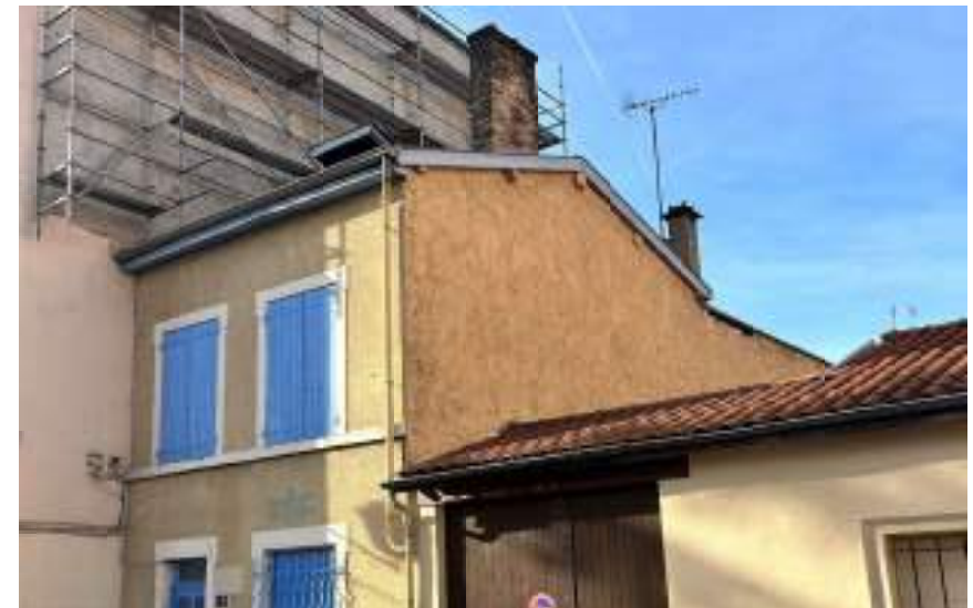
Fig. 2 - Muro divisorio in pisé, nel quartiere lionesse di Saint-Just.
