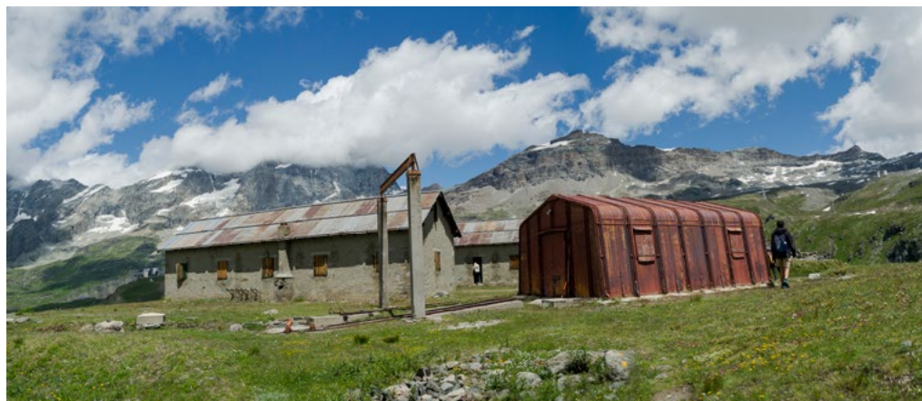
1: Alcune infrastrutture realizzate per la costruzione della diga del Goillet e solo parzialmente rimosse.
