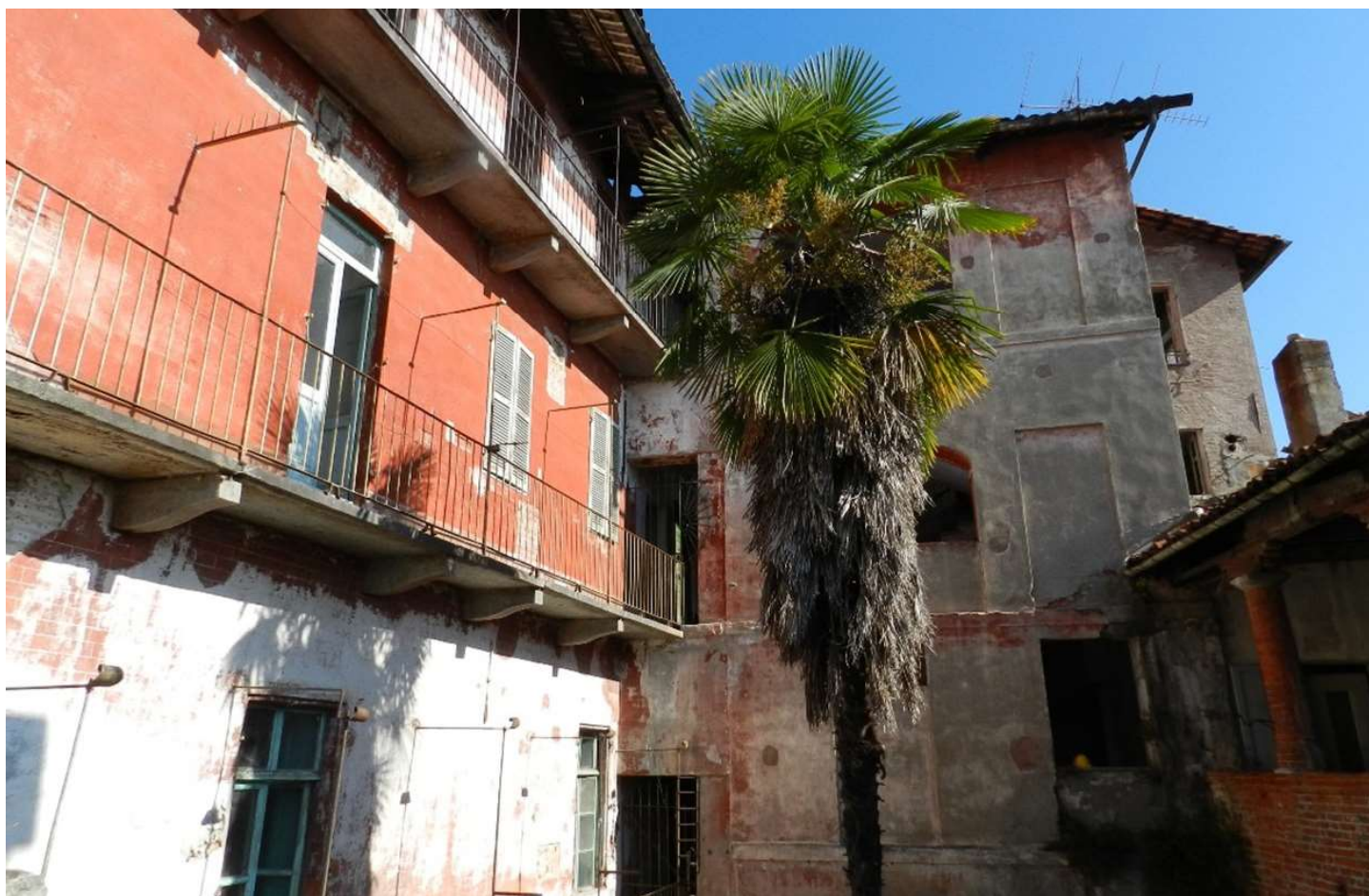
Figura 4. La fachada sur del ala interior del patio en la que se ha encontrado, gracias a la investigación con la cámara termográfica, una abertura ojival con moldura, ocultada por las campañas de construcción posteriores.
