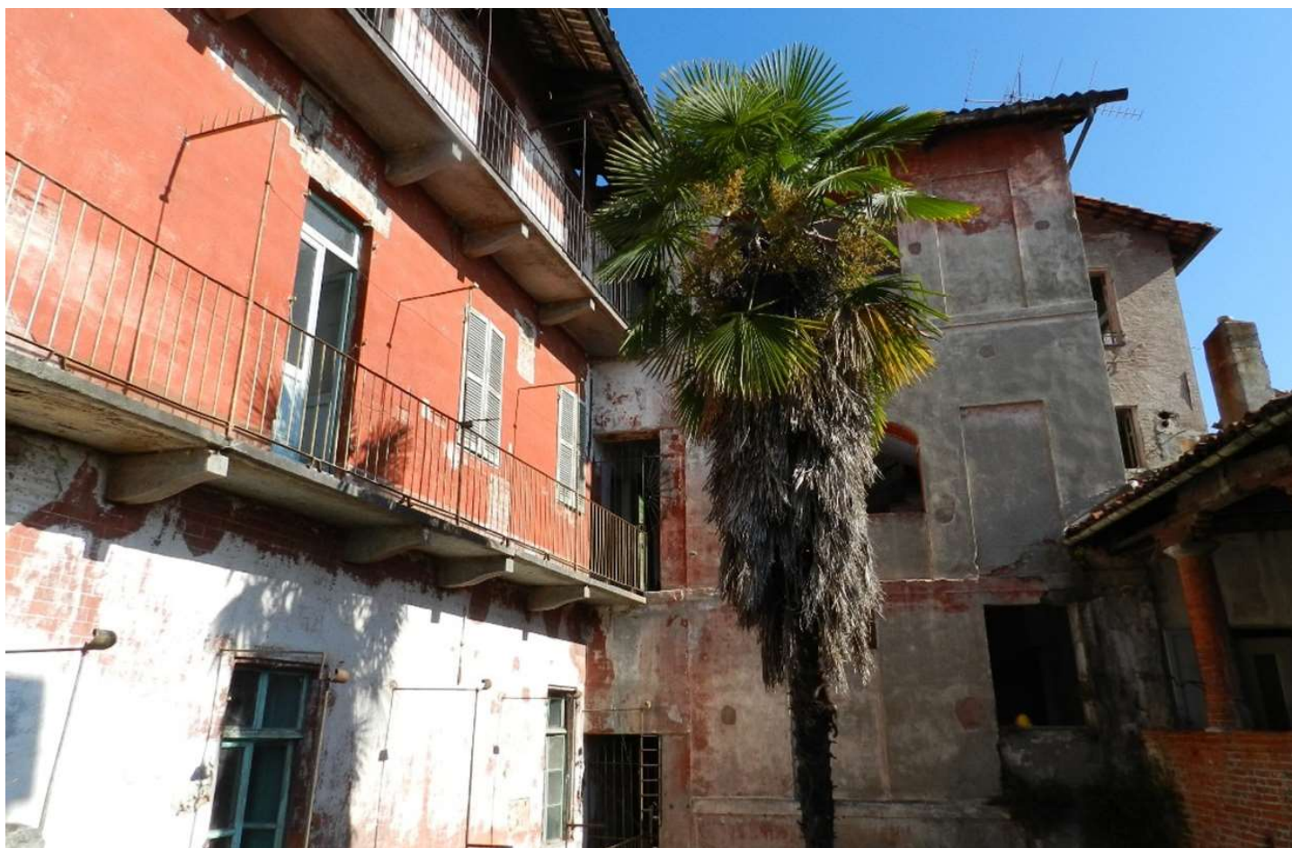
Figura 4. La fachada sur del ala interior del patio en la que se ha encontrado, gracias a la investigación con la cámara termográfica, una abertura ojival con moldura, ocultada por las campañas de construcción posteriores.
