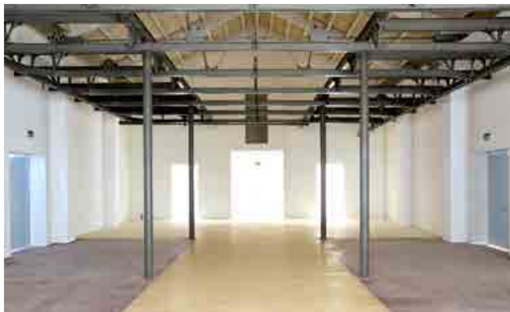
4: Vista interna dell'ex Mattatoio di Pescara, oggi nuova sede dello Spazio Matta, centro per le arti contemporanee. Si noti la conservazione del sistema di guidovie per il trasporto degli animali sottoposti a macellazione. (C. Verazzo 2021)
