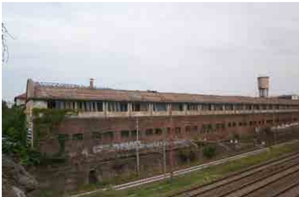
2: Oddi R. F., Ambito OSI-GHIA, veduta parziale dell'area dal cavalferrovia di corso Dante, Torino, 2020 [Fonte: foto Roberta Francesca Oddi 28/07/2020].
