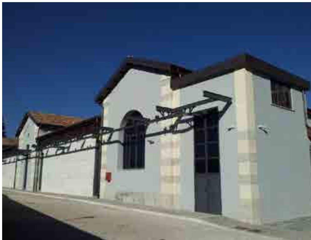
1: Prospetto principale dell'ex Mattatoio dell'Aquila, oggi nuova sede del Museo nazionale d'Abruzzo. Si noti la conservazione del sistema di guidovie per il trasporto degli animali sottoposti a macellazione. (C. Verazzo 2020)
