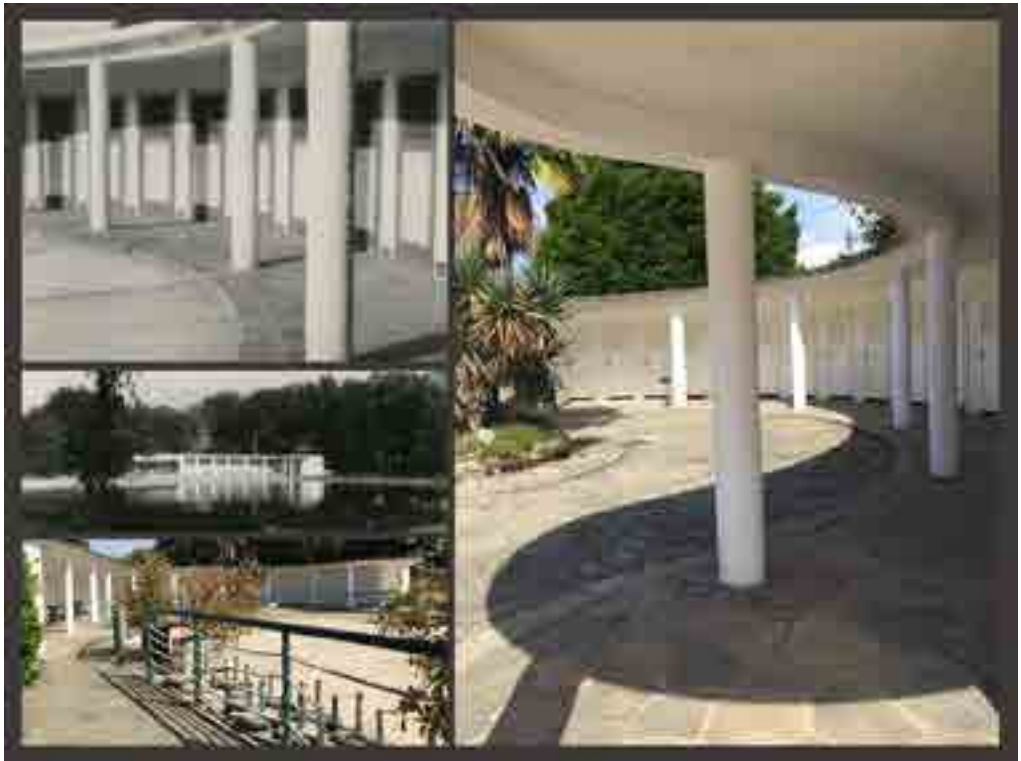
4: Il sapiente gioco di luce e ombre generato dalle forme sinuose delle geometrie degli spogliatoi a ridosso della piscina: fotografie d'archivio e attuali a confronto.
