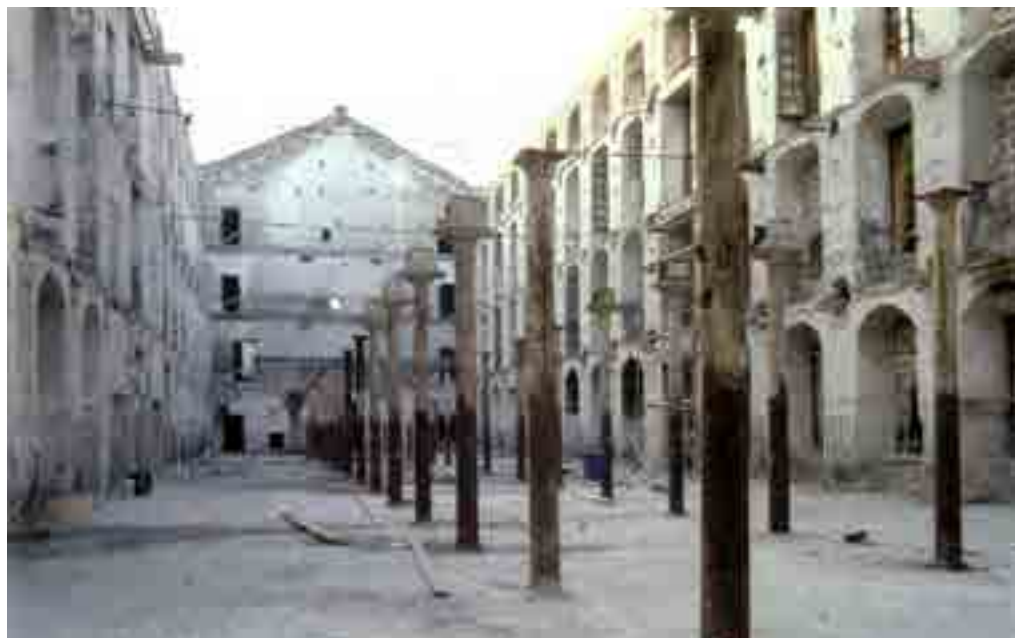
4: Il corpo centrale della Filanda D'Andrea durante i lavori di restauro del 1987 [Di Domenico 2016].
