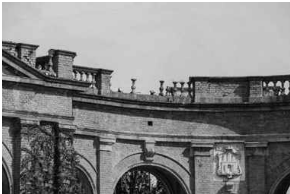
5: Mirogoj, danni causati dai due terremoti nel marzo e dicembre 2020 al sito. Oltre ai danni strutturali, sono stati gravemente danneggiati tombe, padiglioni e i portici.
