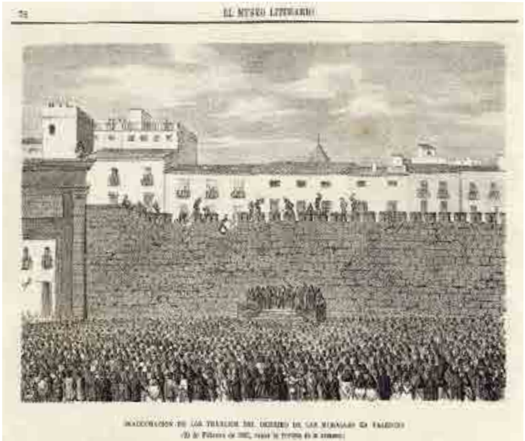
3: Inaugurazione dei lavori di demolizione delle mura a Valencia (20 febbraio 1865. El Museo Literario: periódico semanal de ciencias, literatura, artes, industria y conocimientos útiles , n. 9, 26 de febrero de 1865. Archivo de la Villa de Madrid, Hemeroteca Municipal, A.M. 23/3 (3695).
