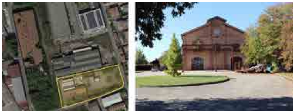
1: Stato di fatto dell'area di studio dello stabilimento dismesso Boranga a Montebelluna: vista aerea con evidenziato il perimetro dell'area; vista dell'edificio preesistente vincolato.
