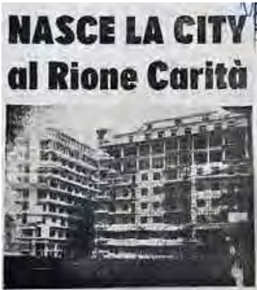
2: Napoli: Rione Carità. Lavori di completamento dei nuovi alti blocchi edilizi del quartiere, in «Napoli Notte», 26 ottobre 1956 (Archivio di Stato di Napoli).
