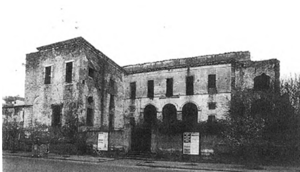
4: Aversa, l'ex complesso agostiniano alla fine del '900 [Cecere, 1998, 53]. Il fronte d'ingresso evidenzia le forti perdite materiali subite dalla struttura dagli anni Quaranta in poi.
