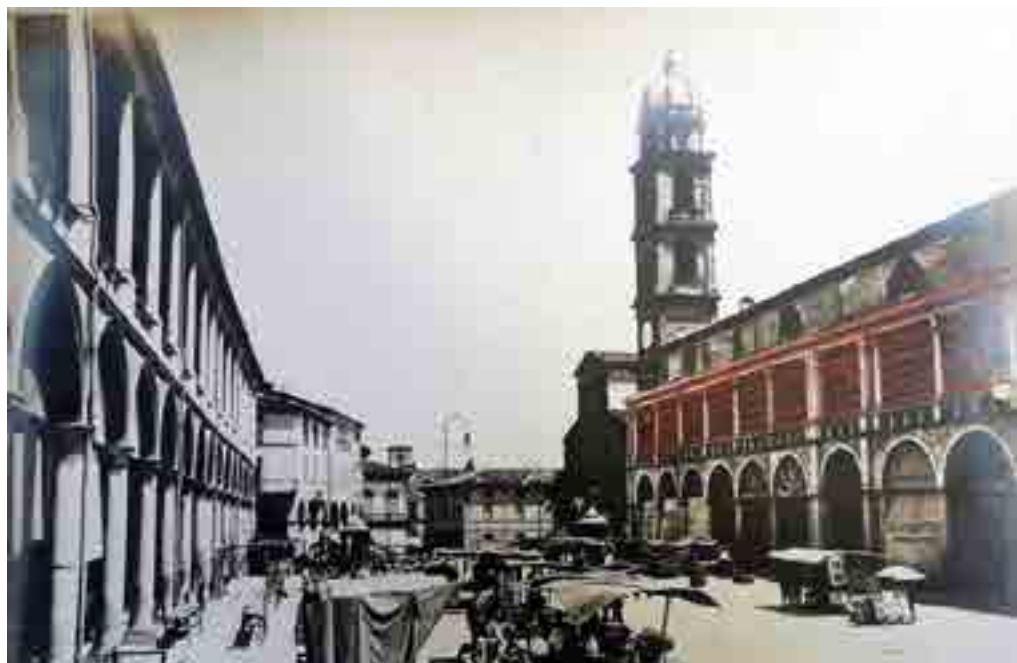
3: Foto Alinari della piazza Vittorio Emanuele ritoccate da Fasolo con ipotesi di sistemazione del loggiato del Palazzo del Podestà [Roma, Archivio Storico Capitolino, Archivio Fasolo, cart. 65, fasc. 1, foto V].
