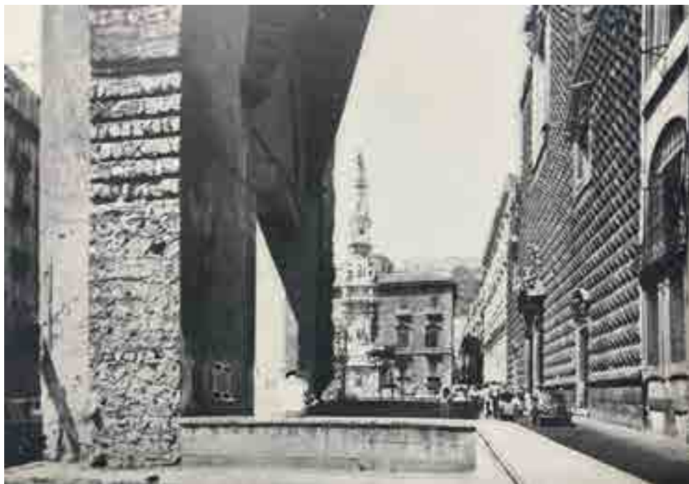
4: La situazione dell'ingresso al sagrato di Santa Chiara prima della sistemazione definitiva in una fotografia di Roberto Pane. Si noti la posizione del portale e della gronda ogivale arretrati di due metri rispetto al primitivo ciglio stradale [Pane R. et al. 1971].
