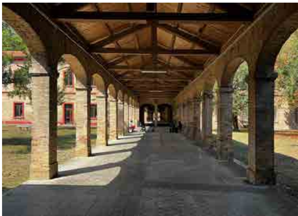
4: Ex Manicomio provinciale di Ancona, 2022 [foto dell'a.]
