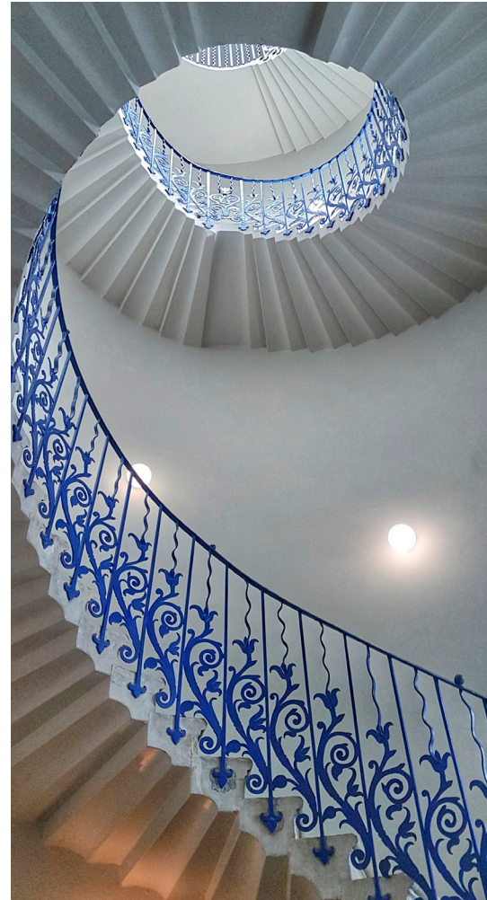
Fig. 8. Queen's House , Greenwich, scala detta "Tulip staircase" (I. Jones), con gradini accuratamente sovrapposti tramite un alloggiamento a L, che impedisce il mutuo scorrimento [©anhistorianabouttown.com].
