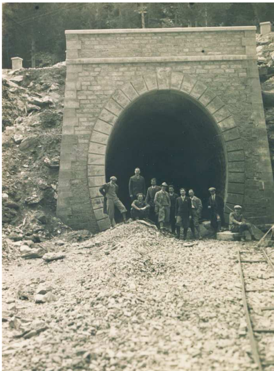
Sopralluogo degli allievi della Scuola di applicazione per Ingegneri di Torino al cantiere del traforo, ASPoliTo, Archivio Storico del Politecnico di Torino
