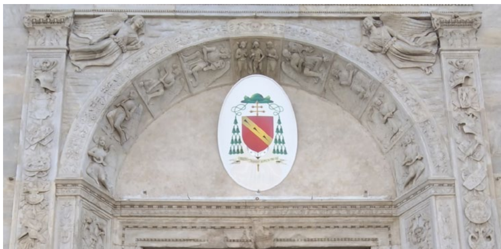
Fig. 6 – Portale centrale. Duomo di Torino.
