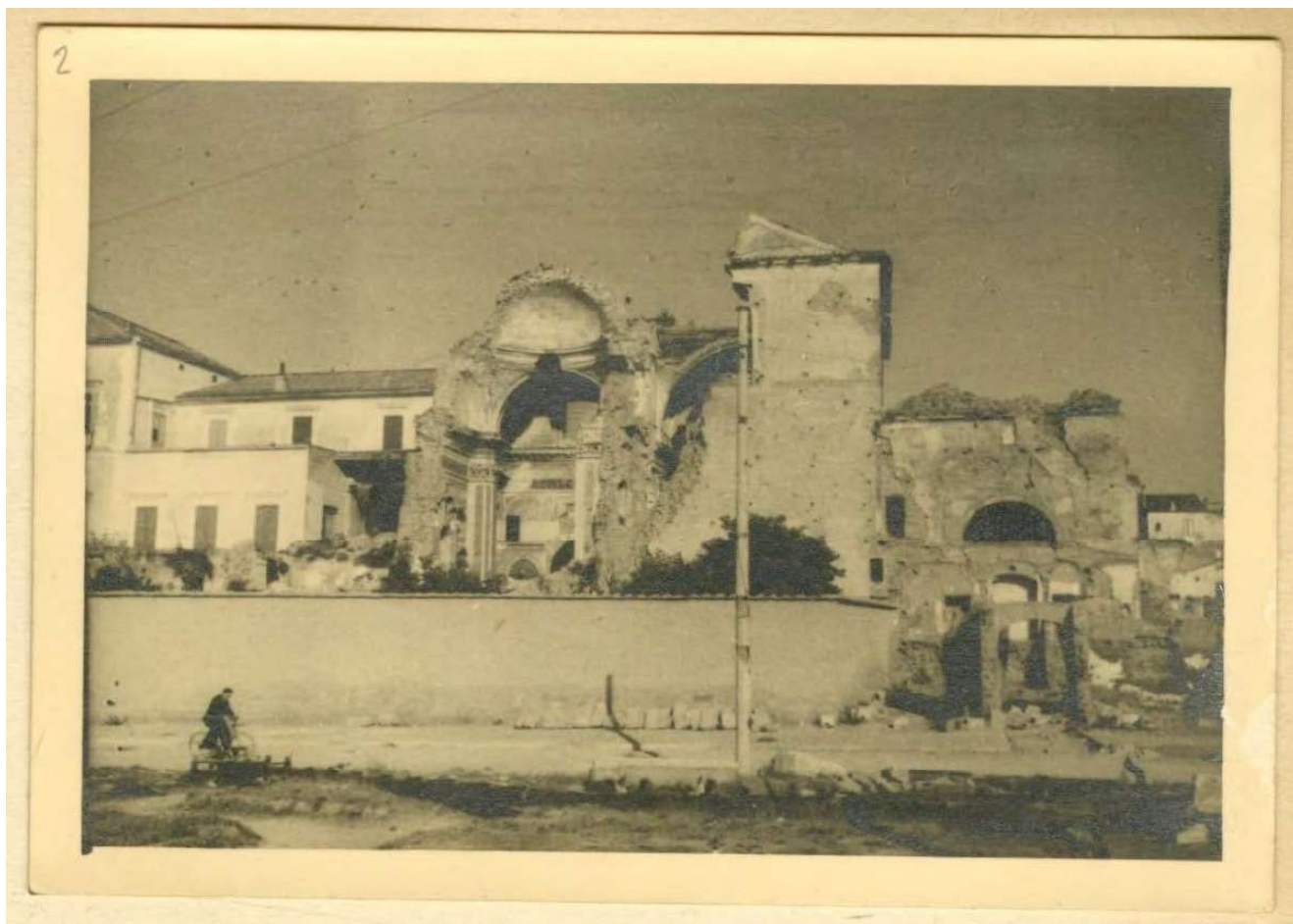
3: Veduta del Duomo dal lungo Volturmo, aprile 1948 (Roma, Archivio Centrale dello Stato, Ministero dei Lavori Pubblici, Direzione generale servizi speciali, Danni di guerra. Ripristino edifici attinenti al culto e alla beneficenza, B. 55, F. lo 52).
