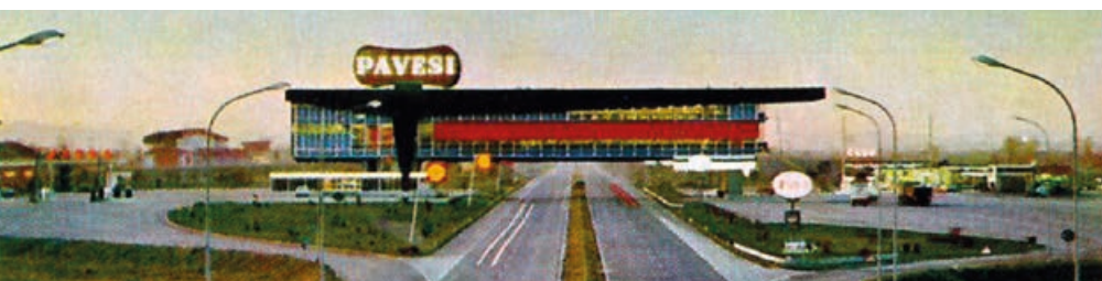
Fig.7 - L'autogrill di Montepulciano in una immagine frontale che mostra l'architettura come struttura ad arco ed elemento di collegamento (Archivio Storico Barilla)
