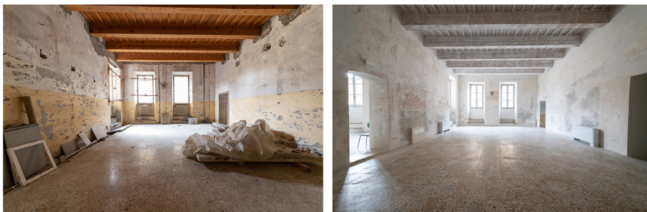
Fig. 4. Palazzo Muglioni: stato di fatto prima e dopo l'intervento finanziato con il bando Rigenerazione urbana in aree interne (foto CasermArcheologica 2021).
