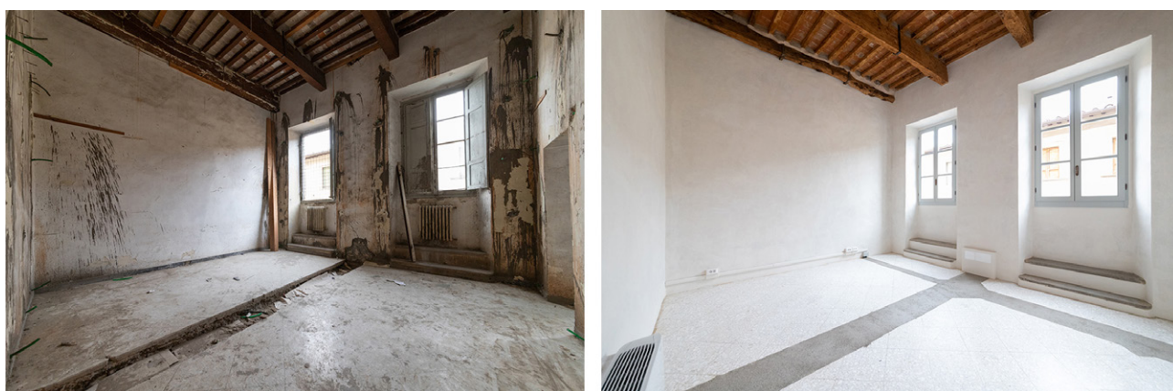
Fig. 5. Palazzo Muglioni: stato di fatto prima e dopo l'intervento finanziato con il bando Rigenerazione urbana in aree interne (foto CasermArcheologica 2021).
