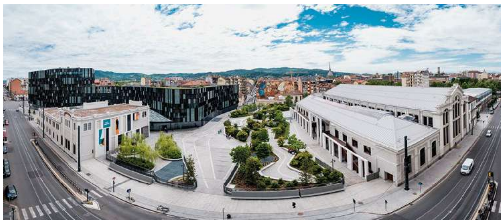
1: Panoramica dell'esterno della Centrale Nuvola Lavazza.
