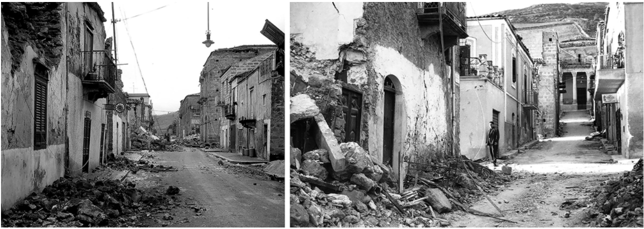
Fig. 3. Poggioreale all'indomani del sisma. Sono evidenti le macerie dei crolli, i quali interessavano solo limitate porzioni degli edifici (per gentile concessione di G. Coco).
