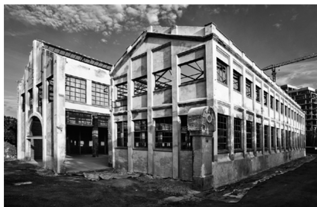
Figura 5. L'esterno della fabbrica prima dell'intervento di Baas Arquitectura (C. Di Felice, 2021).
