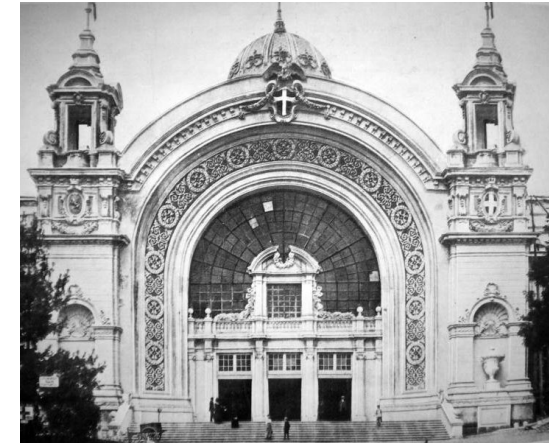
Fig. 1 - Facade of "Palazzo del Giornale", picture b/n. (Mussatti, 2017, p. 10).
