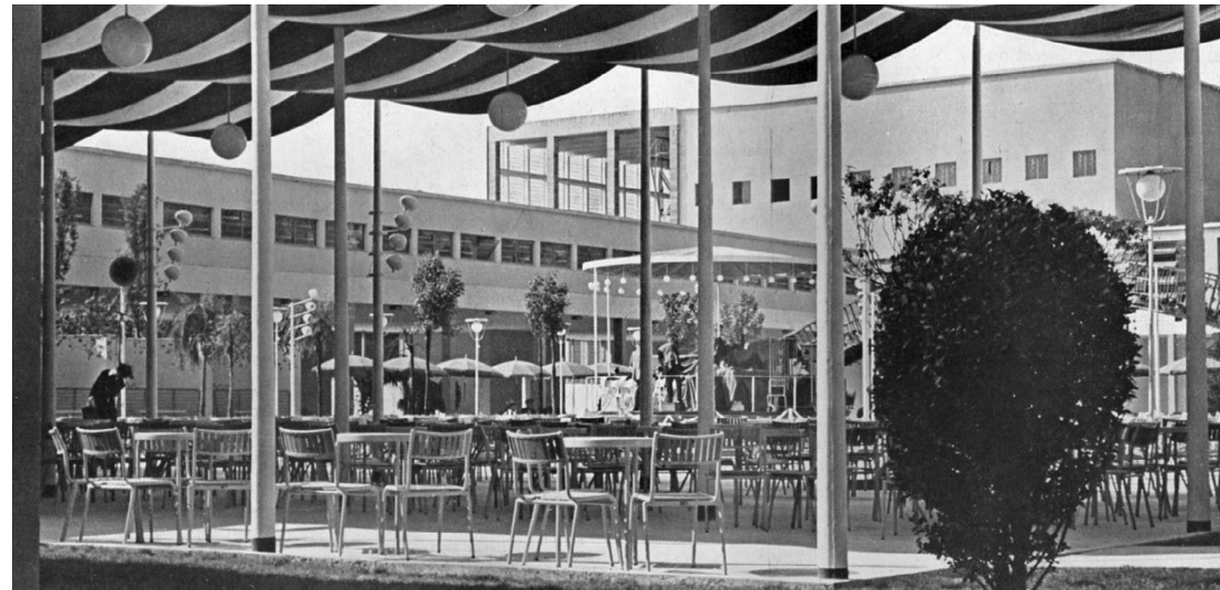
Fig. 4 -Interior view of the dance garden in the Palazzo della Moda, picture b/n. (Casabella n.133, 1939, p. 27, as cited in Mussatti, 2017, p. 113).
