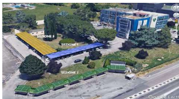
Figura 2: Sezioni costituenti l'impianto fotovoltaico esistente.
