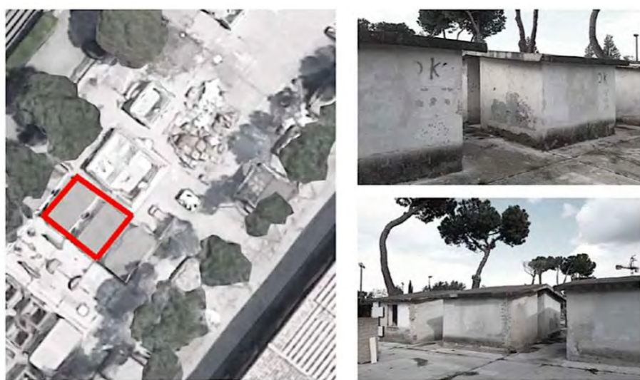
Figura 1. Localizzazione dell'area di cantiere.
