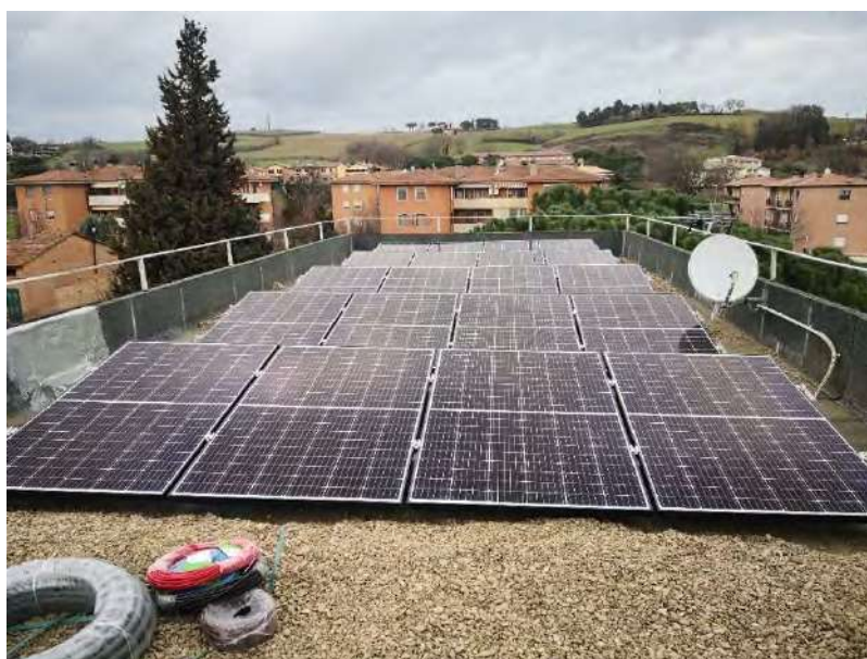
Figura 8: Impianto fotovoltaico installato (vista 1)
