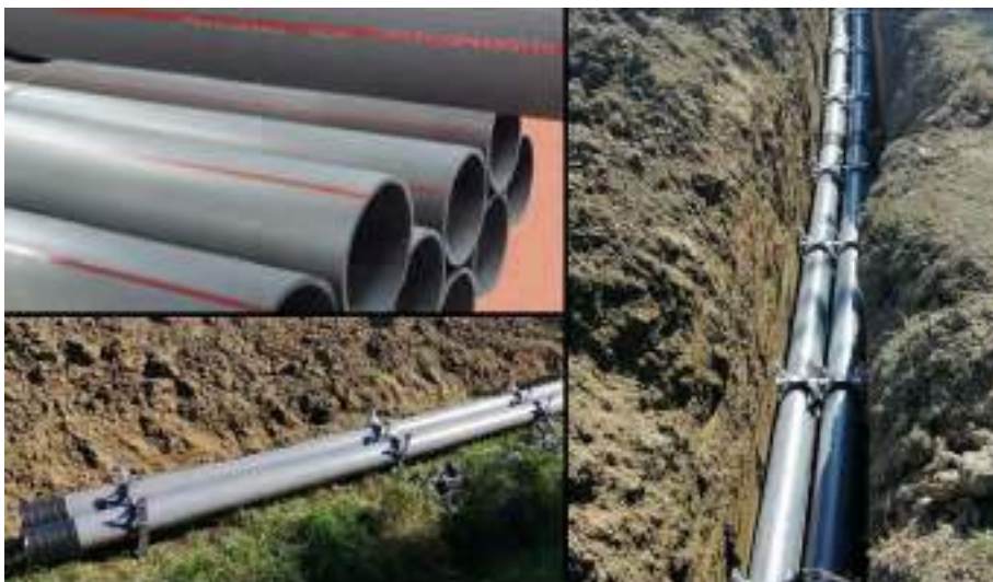
Figura 14 – Immagini del prodotto e di alcune fasi di posa in opera
