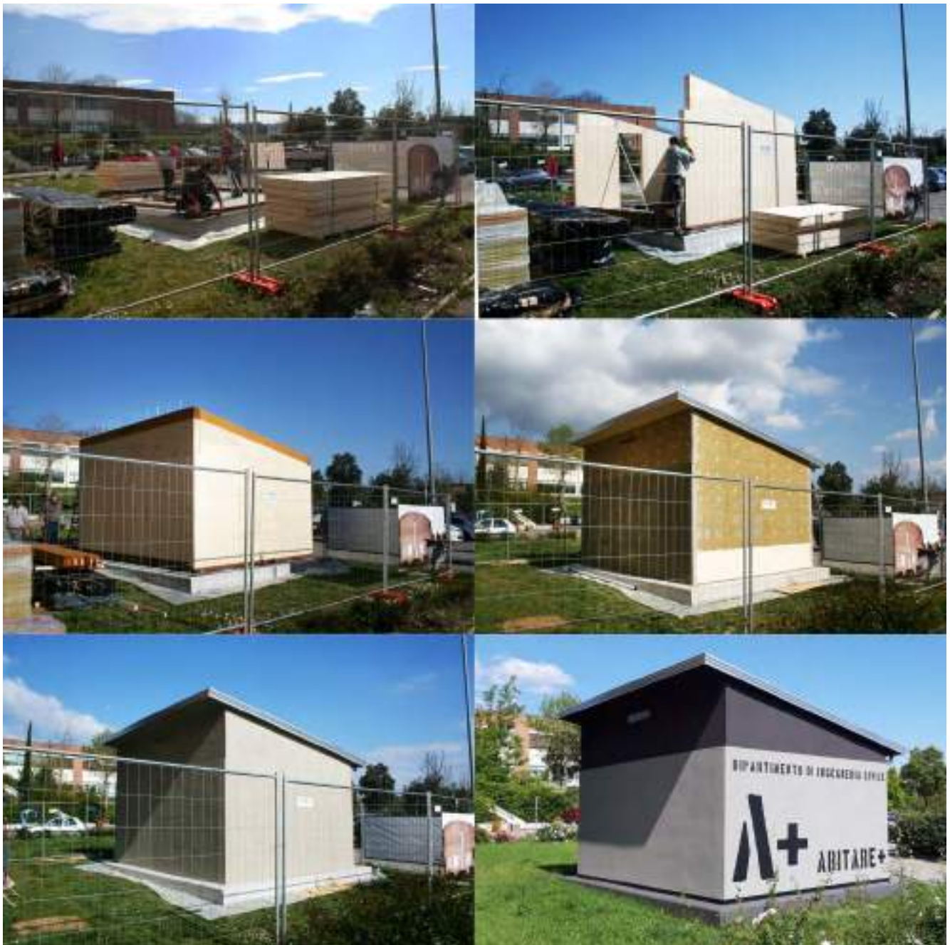
Figura 2. Varie fasi costruttive della test room.
