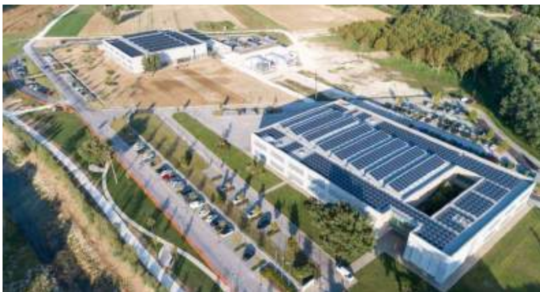
Figura 2. L6 (in alto a sinistra), L4 (in basso a destra) e impianto di cogenerazione (al centro)
