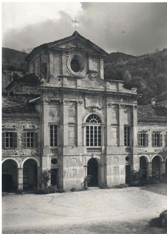
2: Facciata della chiesa realizzata da Bernardo Vittone (Fassini 1940).
