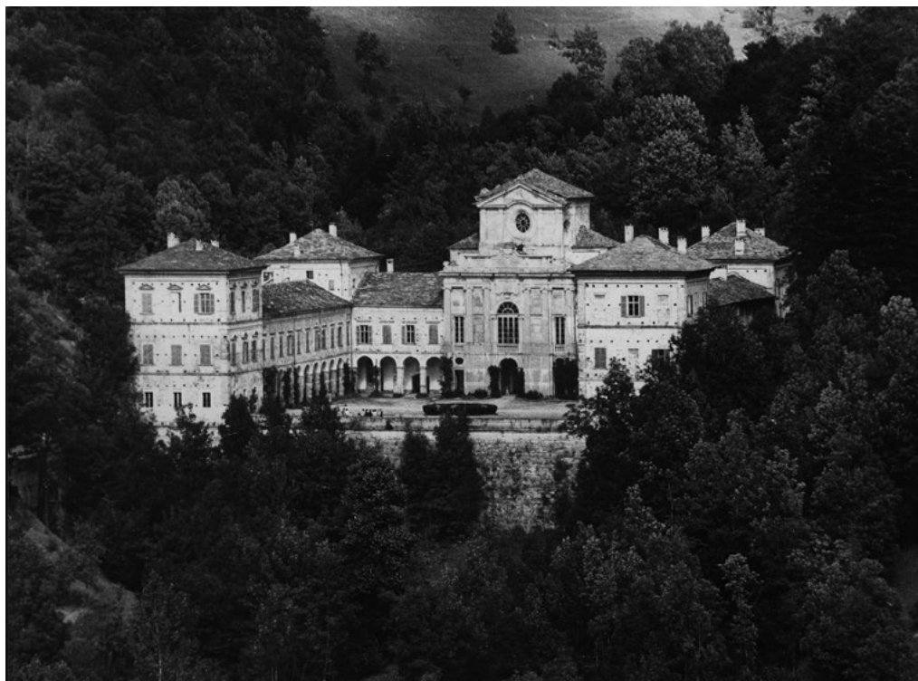
1: Veduta dall'alto del complesso della certosa di Casotto (Fassini 1940).
