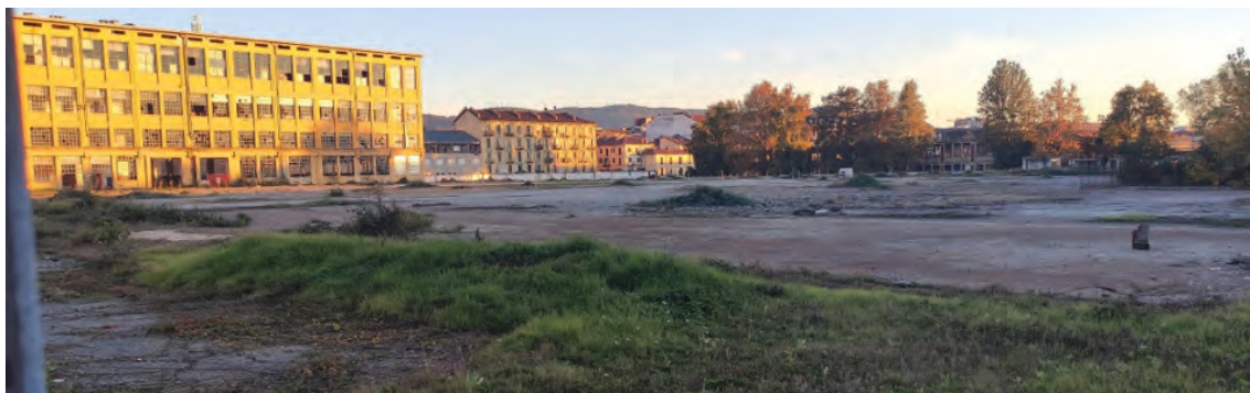
Ex-OGM Officine Grandi Motori –Lotto a nord di via Cuneo Lingottino e area ex industriale in parte abbattuta
