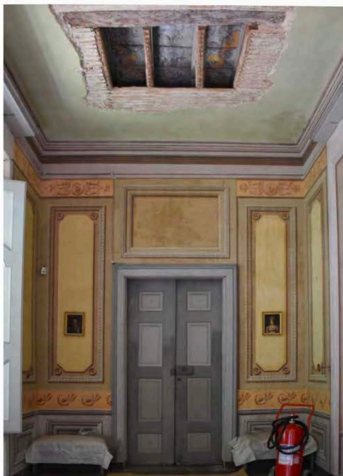
Fig. 5 Castello di Agliè, apertura nel plafone ligneo ottocentesco della Galleria dei morti , 2023. Si intravede la decorazione all'intradosso del solaio preesistente, emersa in seguito alla campagna di indagini diagnostiche condotta nel 2007 (foto D. Arpellino 2022).
