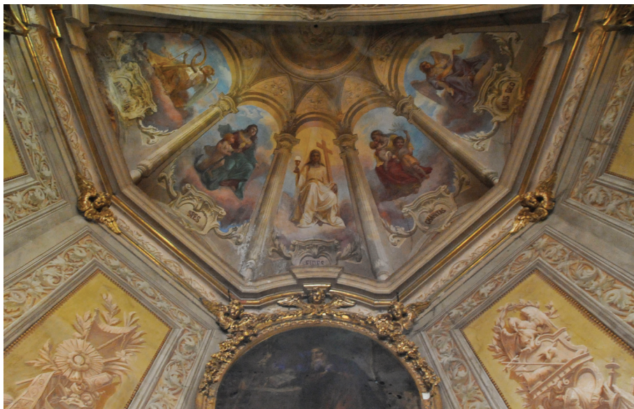
Fig. 10_Particolare dell'abside della chiesa di Sant'Antonio Abate, 2010 (foto di Dino Capodiferro). Il disegno riprende uno dei disegni di progetto conservati in archivio (MC_702a).
