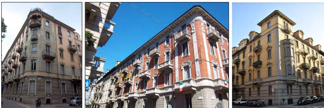
3: Alcuni esempi di architettura Liberty che caratterizza l'area di studio: edifici di pregio realizzati tra Via Luigi Cibrario, Via Amedeo Peyron, Via Claudio Beamount e Via Giacinto Collegno.
