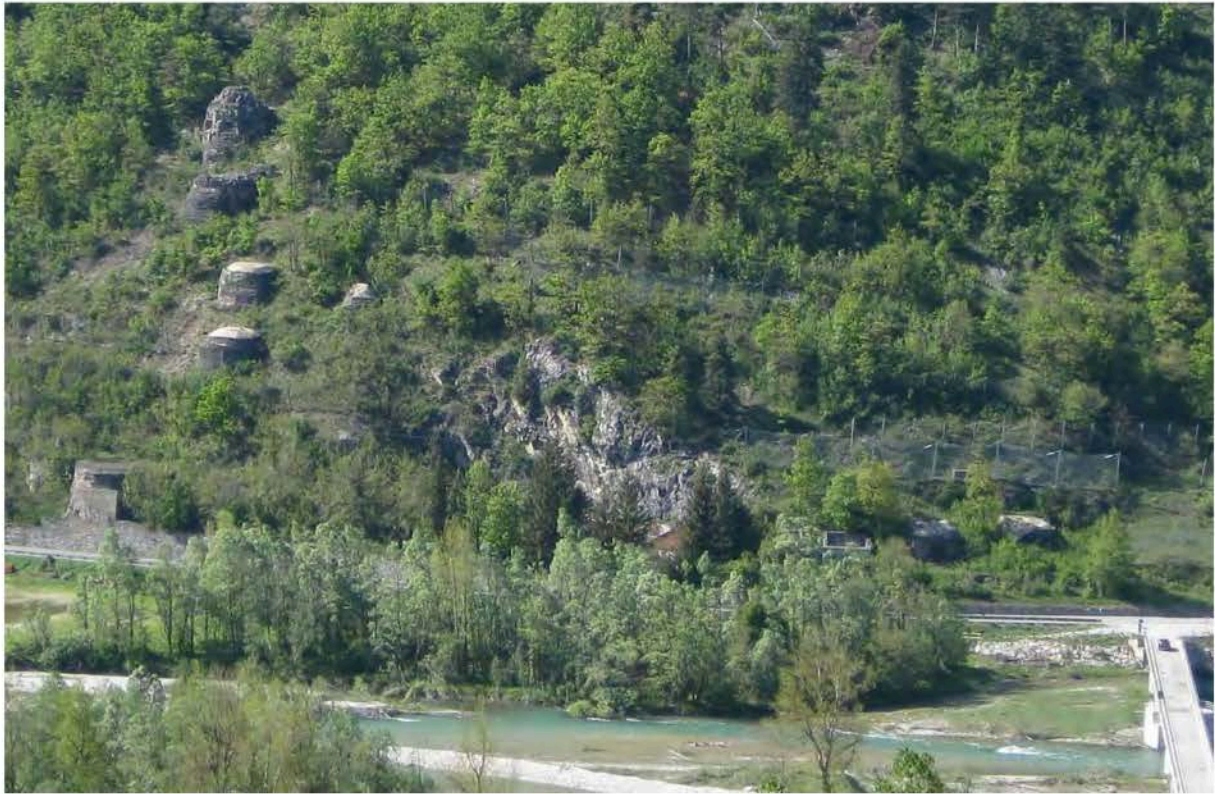
5: L'Opera n. 5 di Moiola si sviluppa lungo la strada di fondovalle in direzione Demonte mimetizzandosi sul costone roccioso. Fonte: arch. Dario Castellino.
