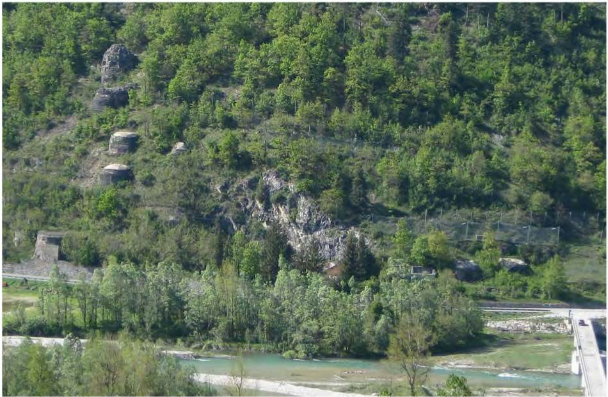
5: L'Opera n. 5 di Moiola si sviluppa lungo la strada di fondovalle in direzione Demonte mimetizzandosi sul costone roccioso. Fonte: arch. Dario Castellino.
