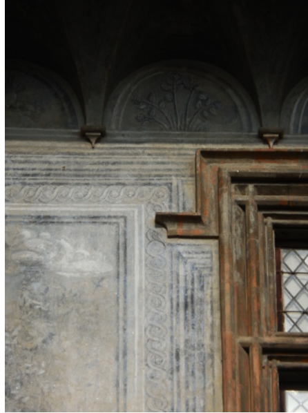
(i) Particolare del terzo livello della facciata
