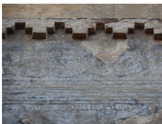
(g) Particolare della fascia marcapiano nel terzo livello della facciata
