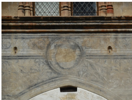
(b) Particolare del primo livello della facciata
