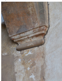
Figura 326: Saluzzo, Casa Cavassa (via San Giovanni, 5), corte (scheda 184)
