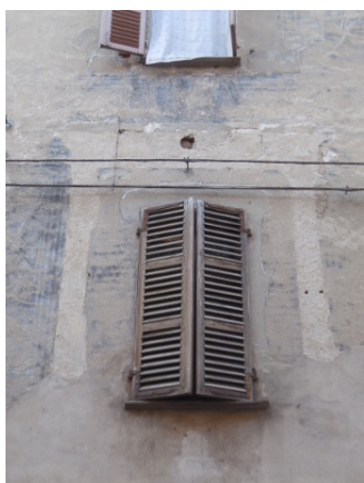
(j) Particolare del secondo livello della facciata con uno dei baldacchini
