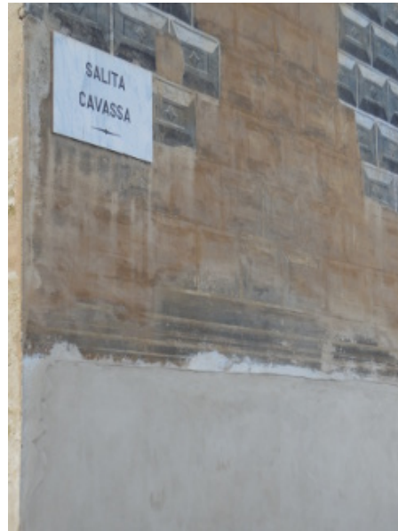
(b) Particolare al primo livello della facciata
