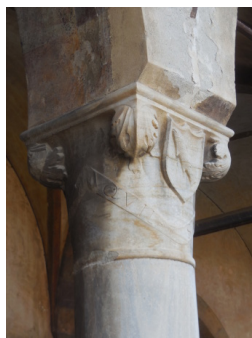
Figura 324: Saluzzo, Casa Cavassa (via San Giovanni, 5), corte (scheda 182)
