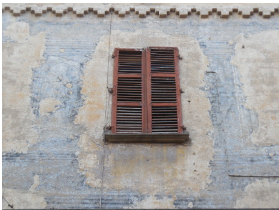
(h) Particolare del terzo livello della facciata
