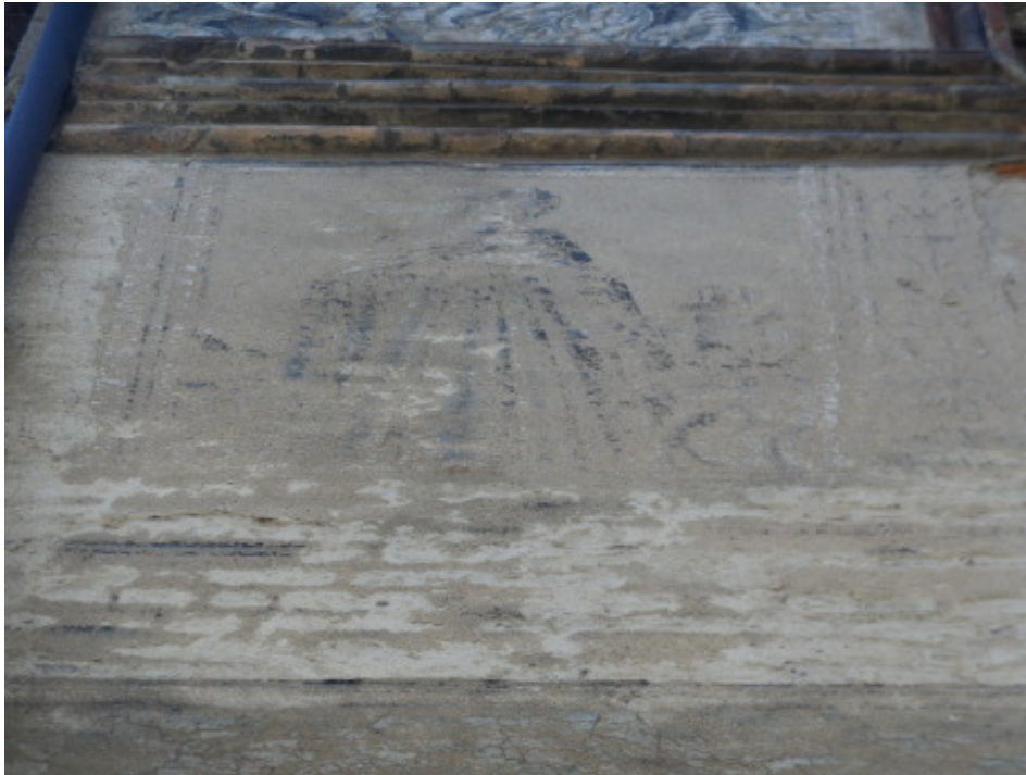
(d) Particolare del secondo livello della facciata
