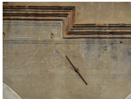
(c) Particolare del primo livello della facciata
