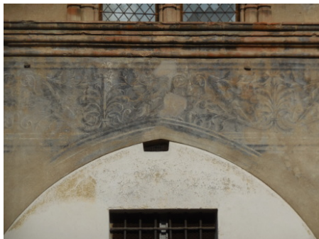
(d) Particolare del primo livello della facciata
