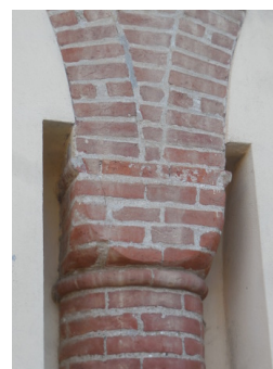
Figura 331: Saluzzo, Casa Pensa (via San Giovanni, 10-12), esterno (scheda 189)
