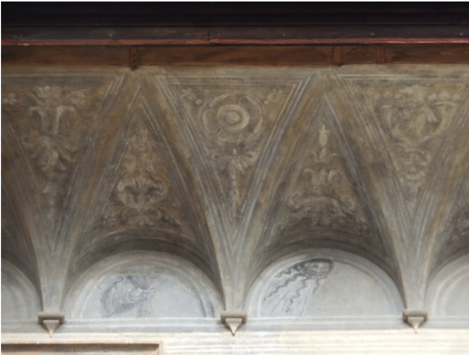
(j) Particolare del terzo livello della facciata
