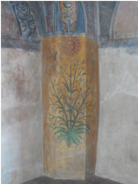
(a) Pilastro tra le pareti sinistra e frontale
