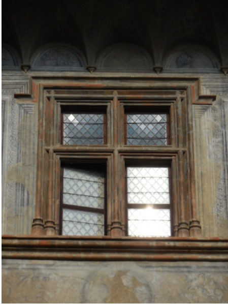
(h) Particolare del terzo livello della facciata
