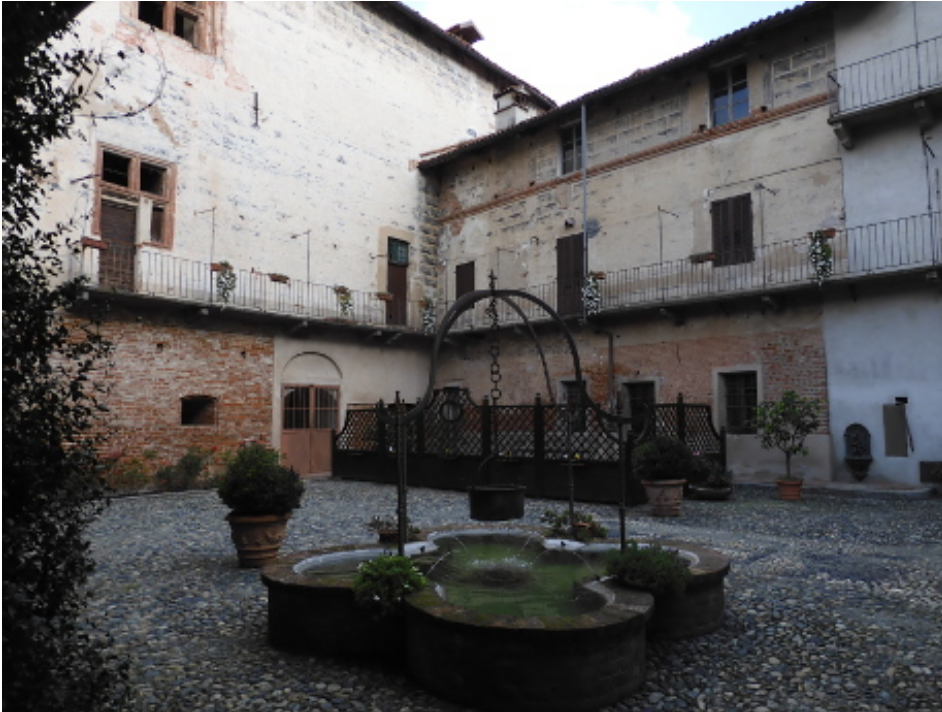
(a) Vista d'insieme dei prospetti nord ed est sul cortile
