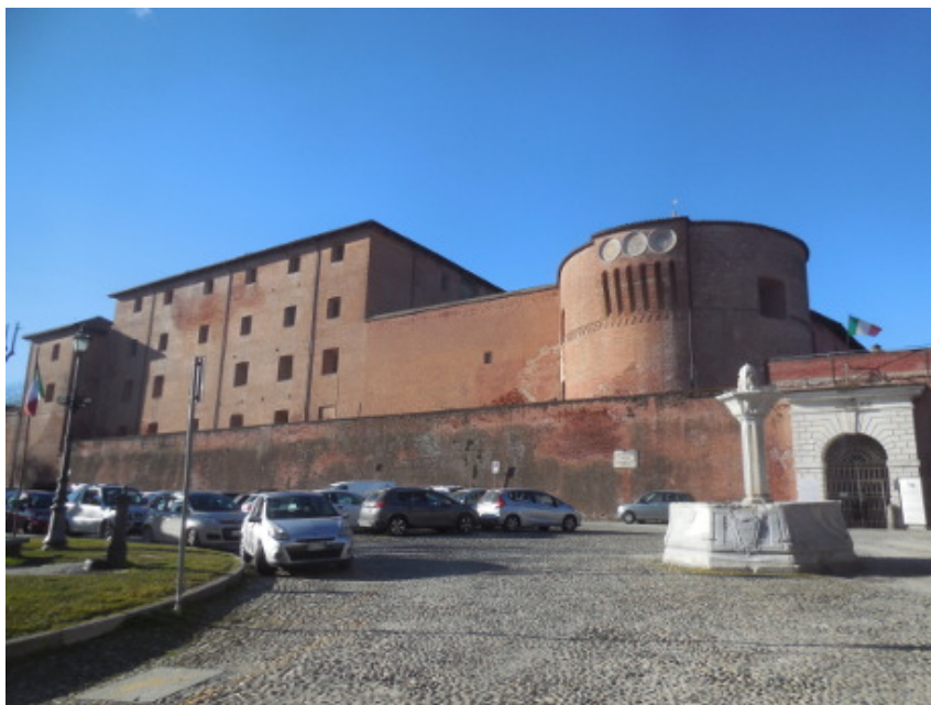
(a) Vista d'insieme del fronte settentrionale: a sinistra l'intervento ottocentesco e a destra il torrione tondo quattrocentesco
