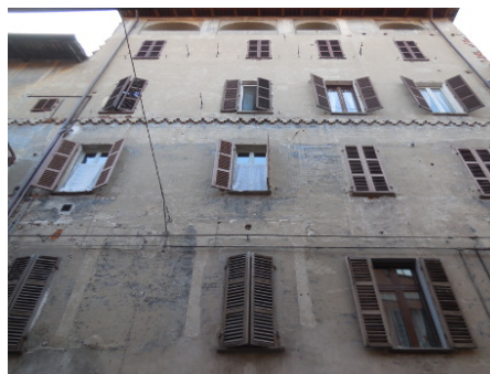
(c) Particolare del corpo centrale
