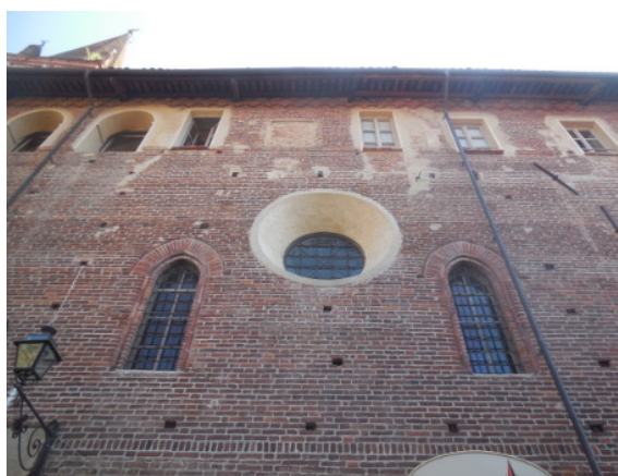
(b) Particolare in corrispondenza della cappella Cavassa
