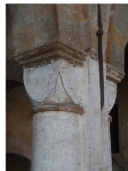
Figura 325: Saluzzo, Casa Cavassa (via San Giovanni, 5), corte (scheda 183)
