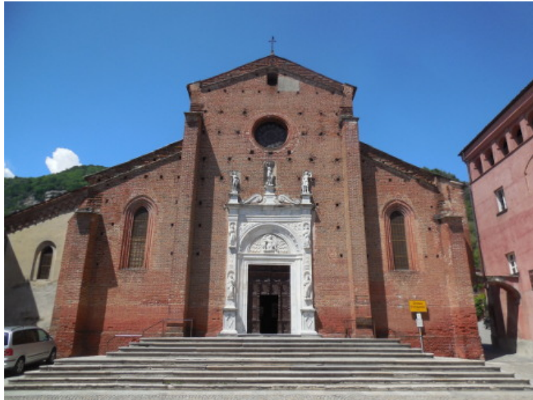
(a) Facciata principale: il portale è un'aggiunta posteriore ed è datato 1534
