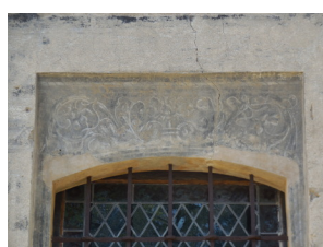
(j) Particolare della lunetta della 5 a finestra da sinistra al primo livello della facciata
