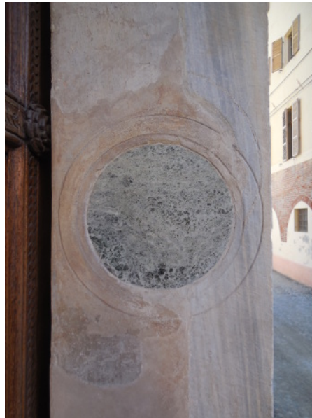
(c) Particolare dell'imbotte
