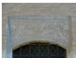
(g) Particolare della lunetta della 2 a finestra da sinistra al primo livello della facciata
