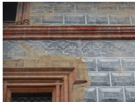
(d) Particolare tra il secondo ed il terzo livello della facciata
