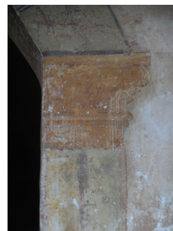
Figura 328: Saluzzo, Casa Cavassa (via San Giovanni, 5), corte (scheda 186)
