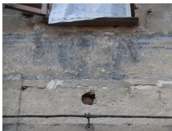
(k) Particolare della fascia marcapiano tra secondo e terzo livello della facciata con ghirlanda e stemma della famiglia Tapparelli in corrispondenza di uno dei baldacchini
