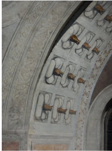
(b) Revello, frazione Staffarda, chiesa abbaziale, facciata
