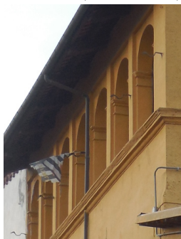
Figura 383: Verzuolo, Casa (via al Castello, 68-70), loggia (scheda 241)
