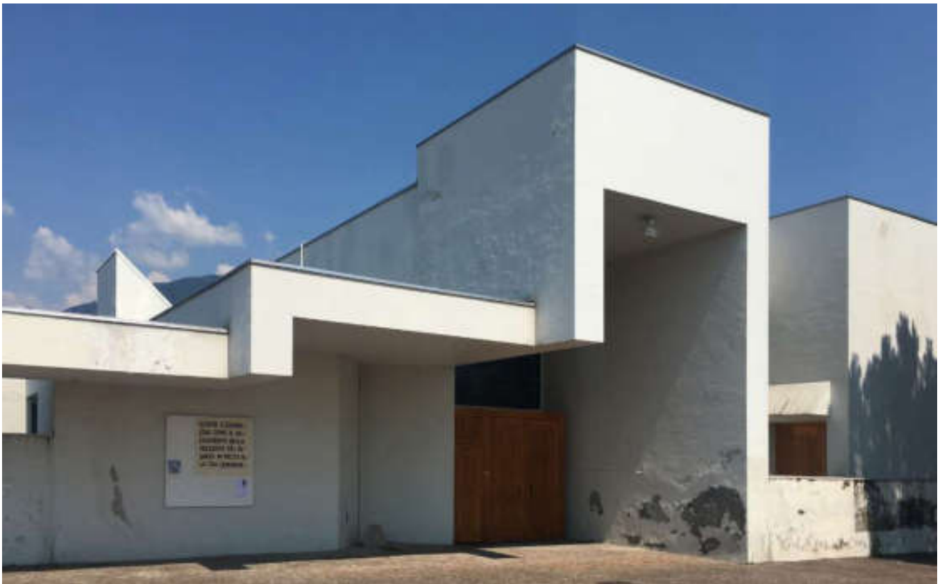
Figg. 9–10 Chiesa e opere parrocchiali di Vajont. Particolare dell'ingresso alla chiesa.
