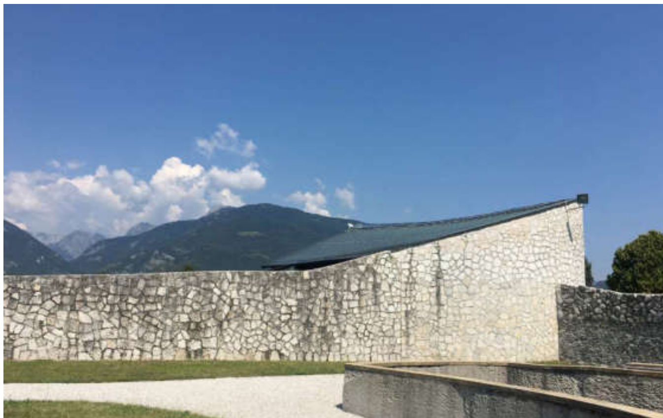
Fig. 1 Cimitero di Vajont. La cappella dall'esterno.
