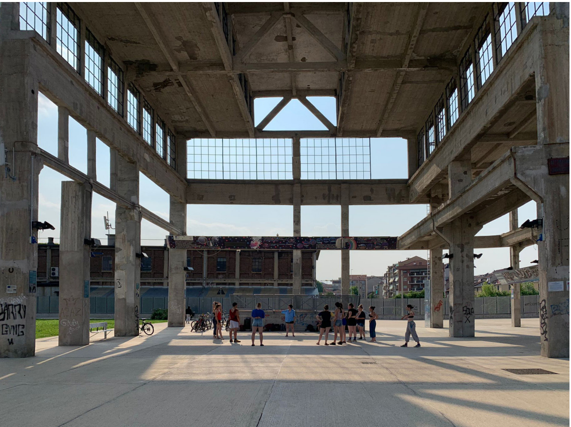
Figura 15. Le capriate Porcheddu nel Parco Aurelio Peccei. Foto di Sara Caramaschi.
