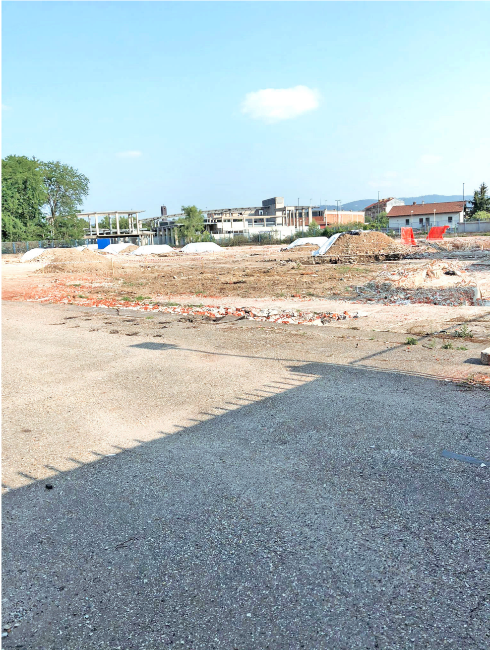
Figura 1. Il grande cantiere in corso Grosseto. Foto di Andrea Ghirardi.
