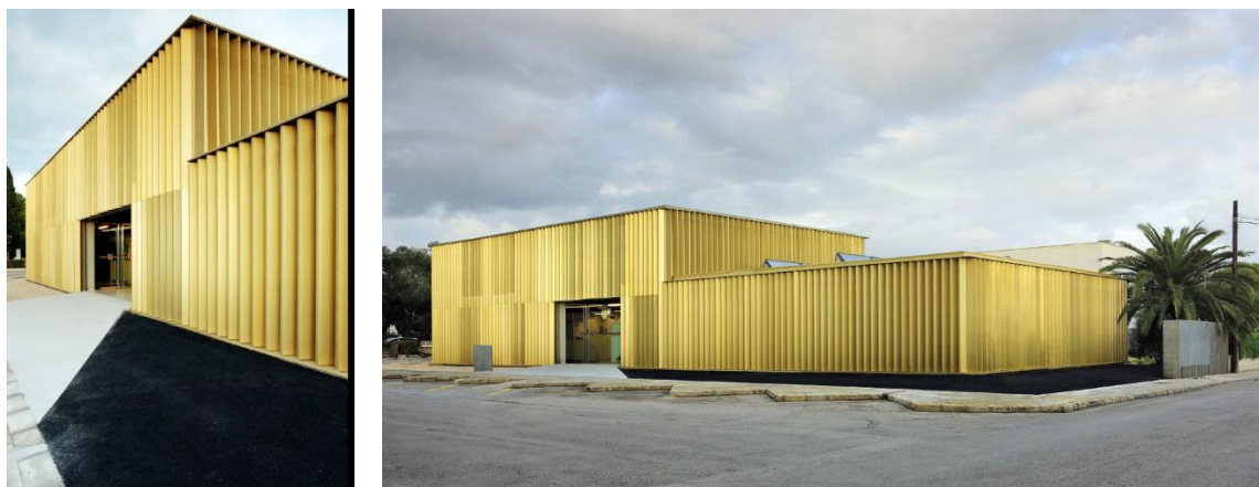
Centro sanitario di Badies (Spagna). L'accesso è identificabile grazie al diverso colore e materiale di pavimentazione che costituisce un "invito" all'accesso
