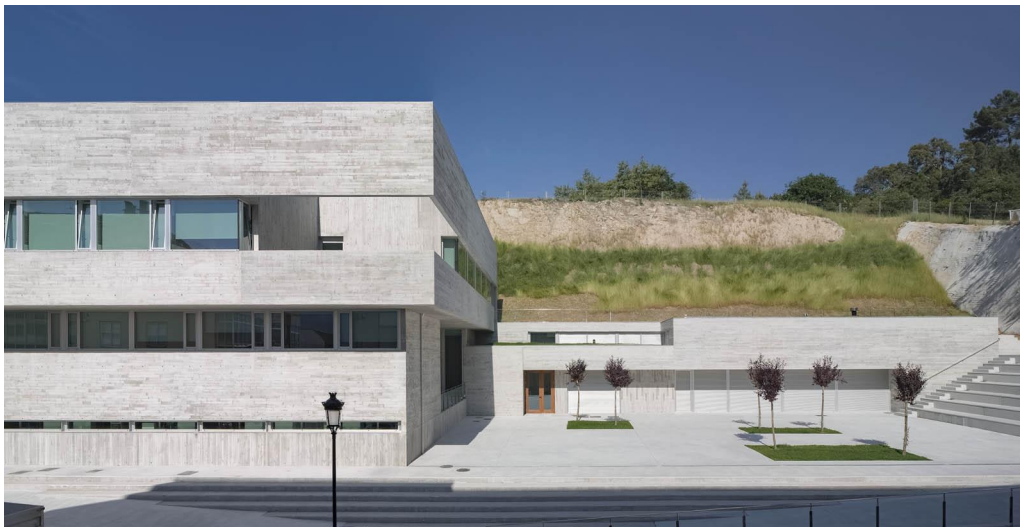
Spazio esterno del Centro Sanitario Valenza a Ourense (Galizia-Spagna)
