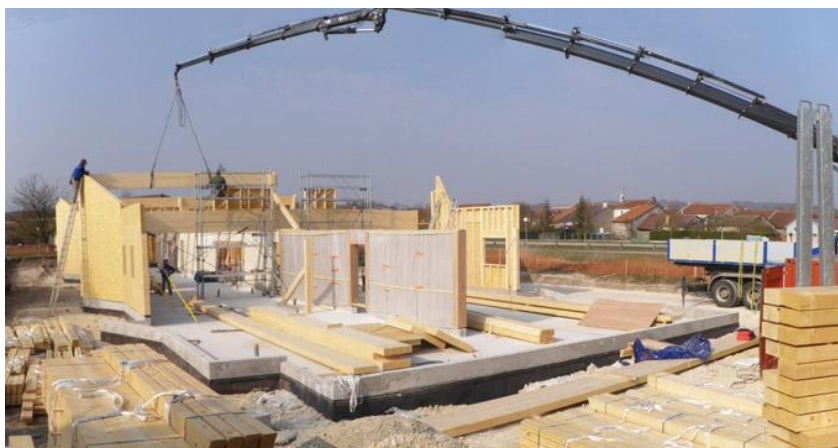
Centro socio-sanitario di Void Vacon (Francia), struttura in telai di legno e travi di legno lamellare.
