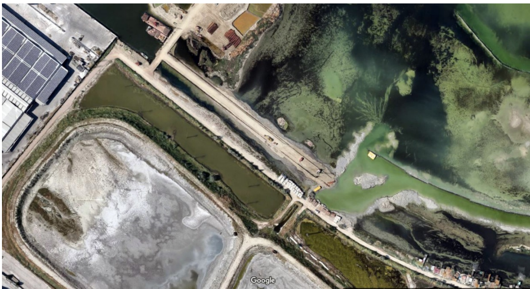
Figura 6 | Ravenna, Pialassa Piomboni, 2018. Costruzione dell'argine sud dell'area SIC-ZPS. Fonte: Google maps
