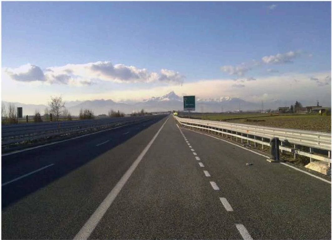
2: Un tratto dell'autostrada A33, verso il Monviso (Paolo Mellano).
