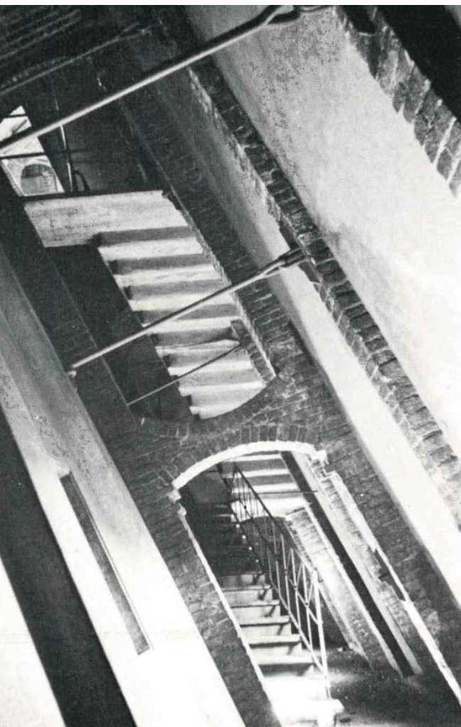
Fig. 5. Archi dritto-rovesci, nell'intercapedine del volto della Mole, a sinistra [Rosso, 1977], e nella cupola di San Gaudenzio, a destra [fotografia dell'autore].
