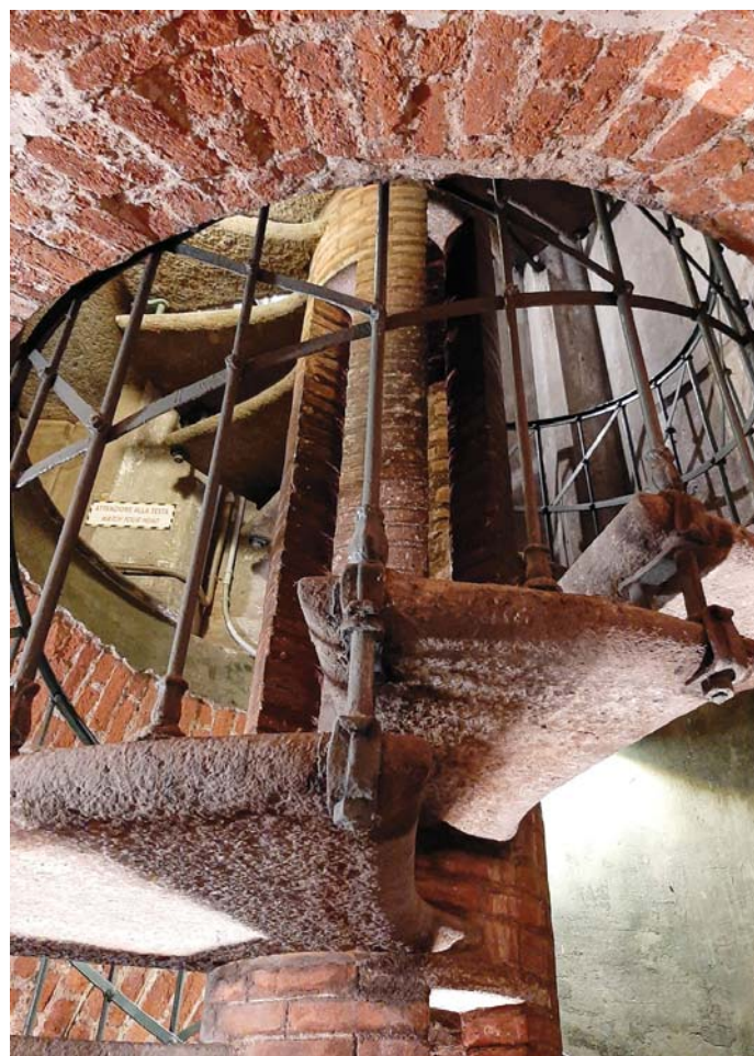
Fig. 4. Scale a sbalzo elicoidali nella Mole: il sistema bilaterale di connessione tra le lastre lapidee – a sinistra nel rilievo di Franco Rosso [Rosso, 1977], a destra in una vista di dettaglio [fotografia dell'autore].
