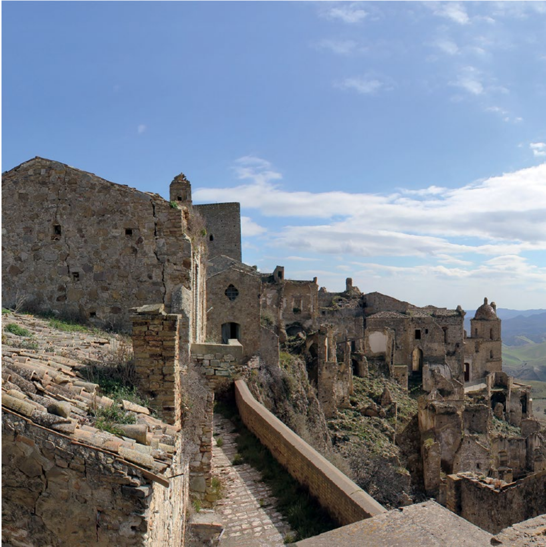
Figura 4. Craco (Matera). Via Alfieri (foto A. Lancellotti, 2016).
