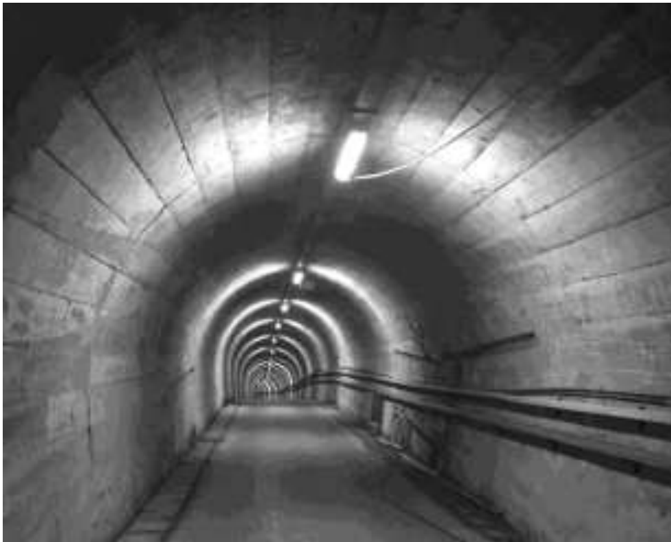
Fig. 4. Foto Galleria di ingresso della ex base NATO West Star.
