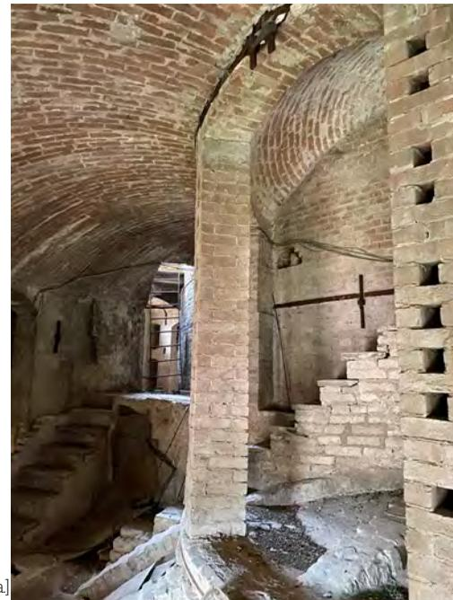
Fig. 20a, 20b. Vista sul piano extradossale della calotta absidale e sistemi di scale in muratura (2021).
