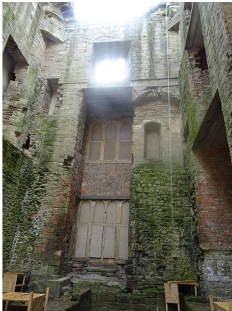
Fig. 6- Castello di Hylton, stato di fatto prima dei lavori di rifunzionalizzazione (foto di S. Adie, 2017)
