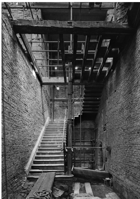
Fig. 3- Castello di Hylton, vista interna prima degli interventi di demolizione, 1950 circa (archivio Historic England, P/A06422/014)
