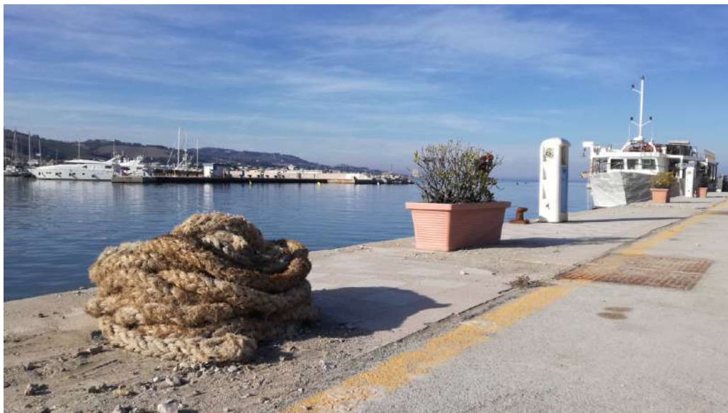
Figura 2 | La banchina “grandi navi” all’interno dell’area portuale di Porto San Giorgio, novembre 2018. Fonte: ©Rigo C.
