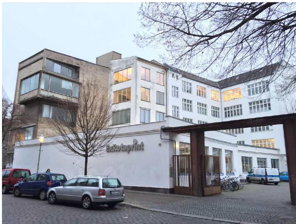
Figura 1 | Ingresso al compound dell'ExRotaprint. Foto (cc): Eutropian
