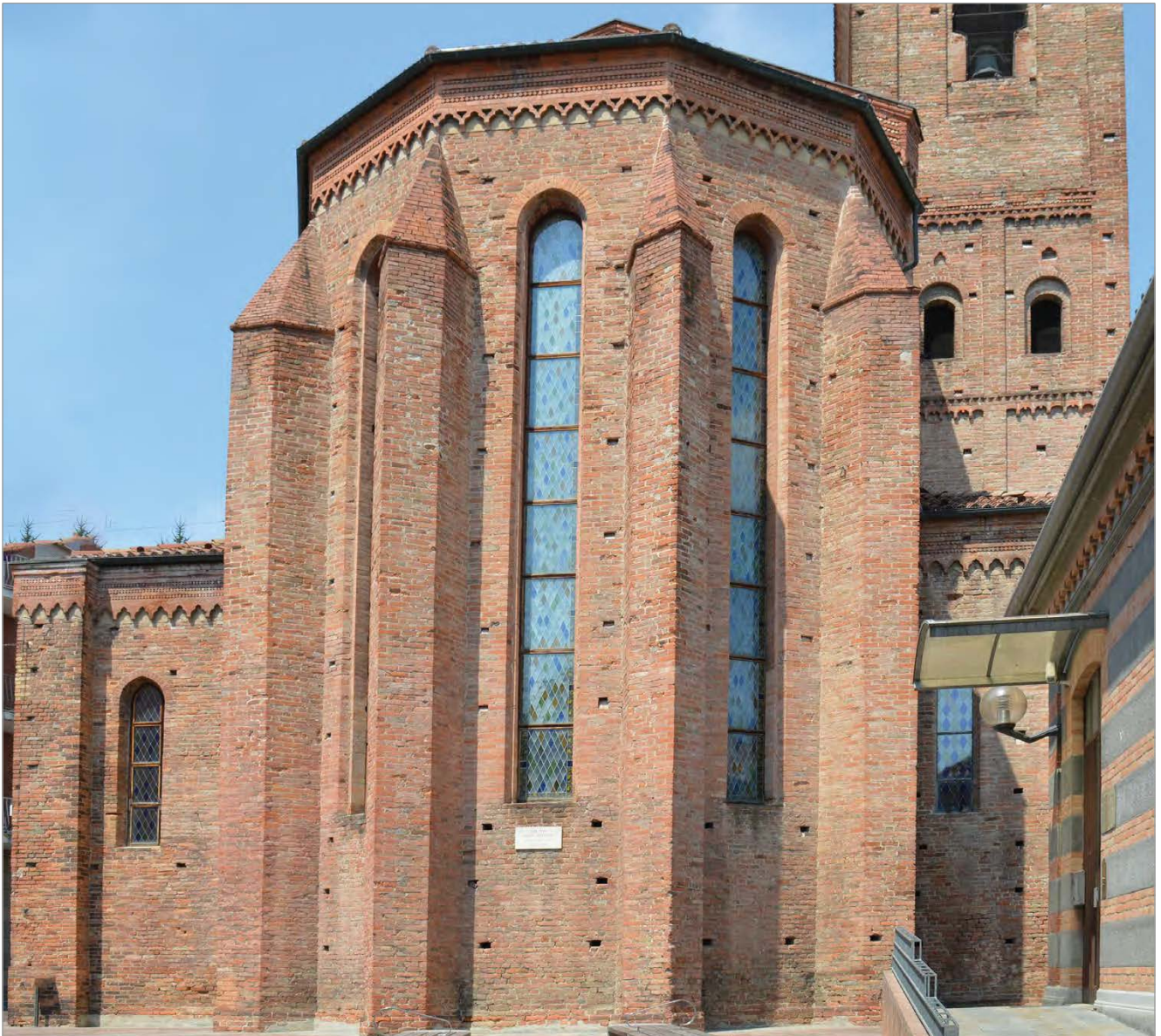
fig. 9 – Alba. Chiesa di San Domenico, esterno dell'abside (foto dell'autrice).
