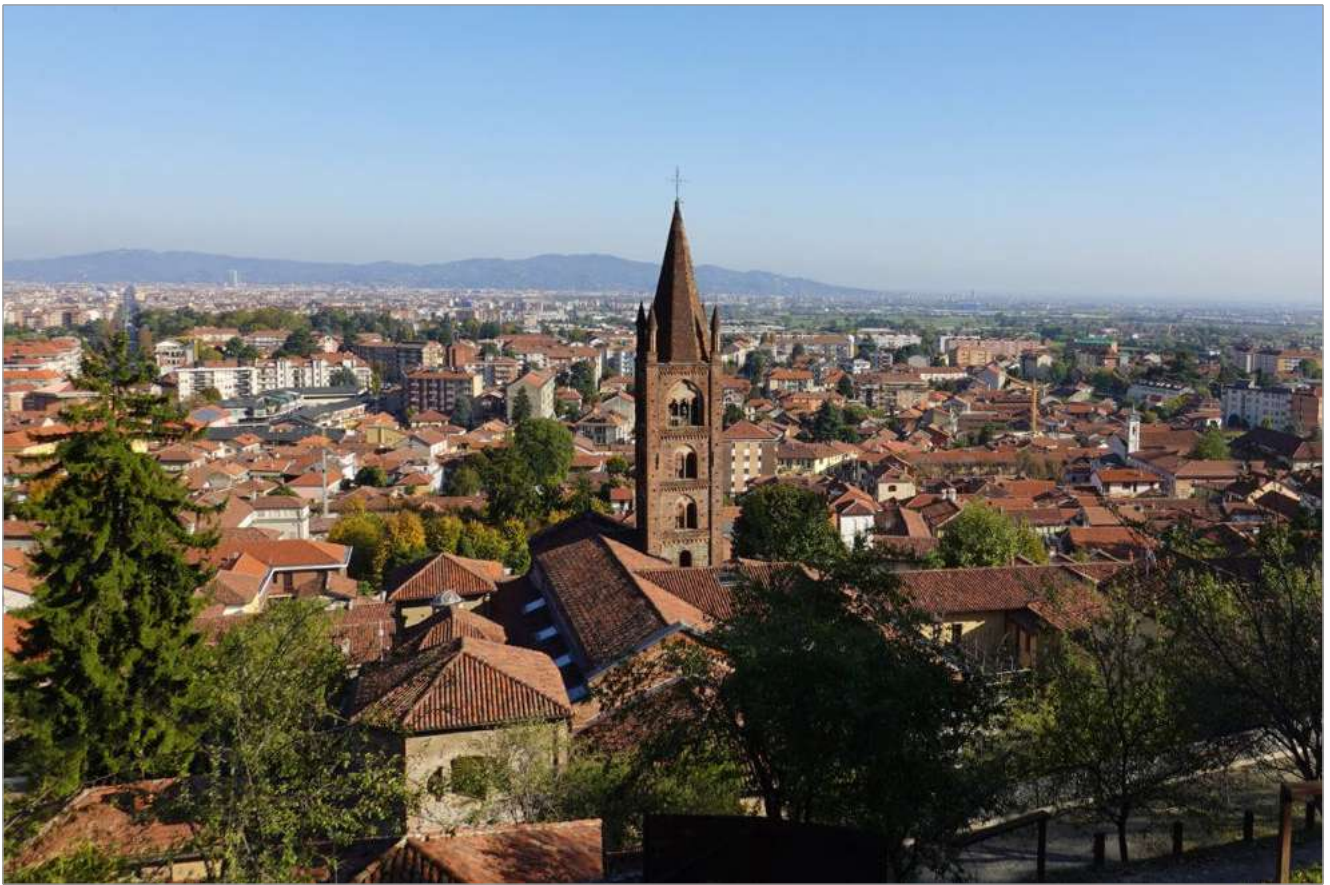
fig. 11 – Rivoli. Santa Maria della Stella (già San Domenico), il campanile si erge sul centro abitato e nel paesaggio urbano (foto dell'autrice).
