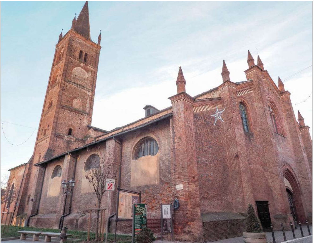
fig. 4 – Chieri. Chiesa di San Domenico, prospetto laterale e fronte principale (foto dell'autrice).
