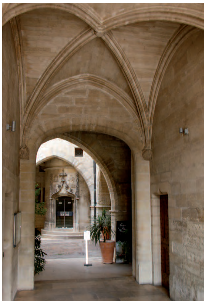
Fig. 15. Avignone. Petit Palais , vestibolo di accesso al palazzo con crociere costolonate su mensole figurate.
