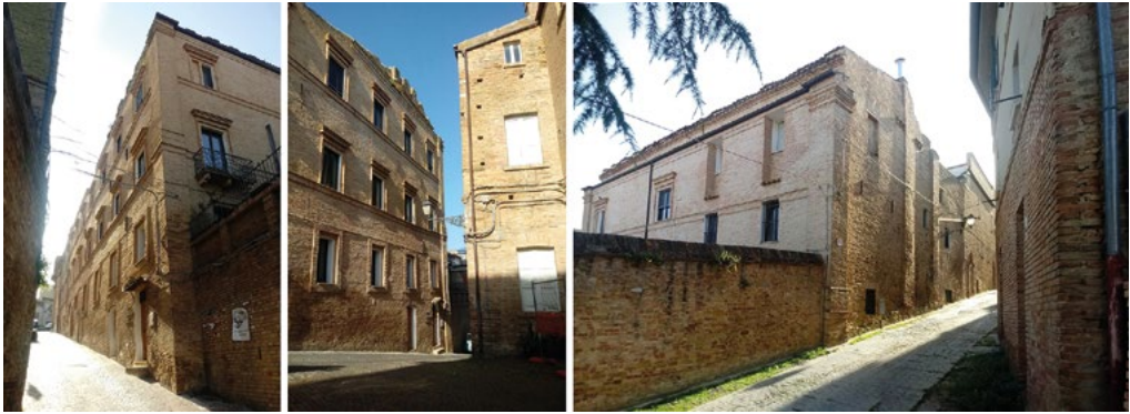
4: Palazzo Scorpione-Quintangeli. Due viste del prospetto principale su Corso dei Vestini (fronte sud) e veduta dei prospetti secondari (sul lato corto, il fronte est, e sulla strada retrostante, il fronte nord). Sul lato ovest, invece, c'è la chiesa di S. Ciro [Fotografie dell'autore].
