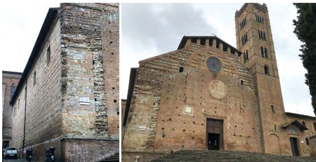
3: La basilica di S. Clemente in S. Maria dei Servi. A sinistra, il fianco est con il paramento a fasce alterne di calcare e laterizi; a destra, veduta d'insieme della facciata, incompiuta, e del campanile [Fotografie dell'autrice].
