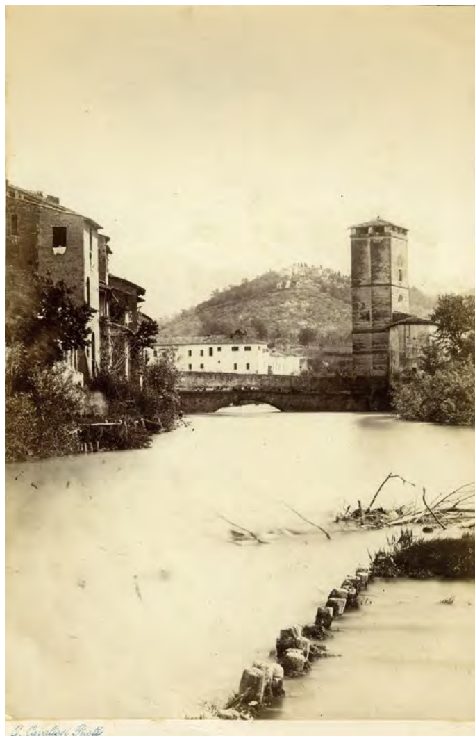
3: Veduta della città dal fiume Velino. Sullo sfondo, il complesso conventuale dei Frati Minori, demolito negli anni '60 del Novecento per costruire il Liceo Scientifico, e il colle Belvedere con il conventino degli Osservanti di Sant'Antonio del Monte, così intitolato in memoria della fondazione del Sacro Monte di Pietà.
