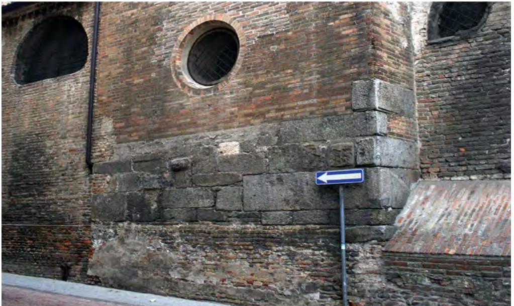
3: Lodi, Tempio di San Francesco, Cappella di San Bernardino – esterno [Fotografia dell'autrice].
