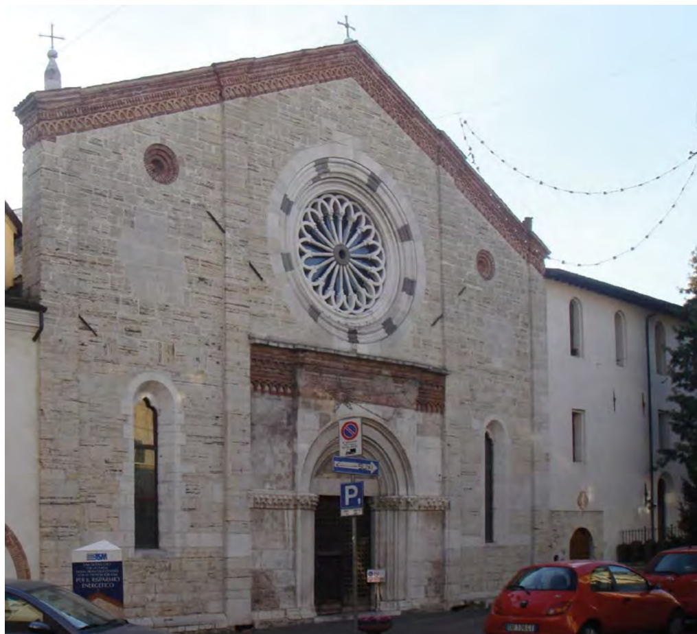
1: San Francesco di Brescia, facciata [Fotografia dell'autore].
